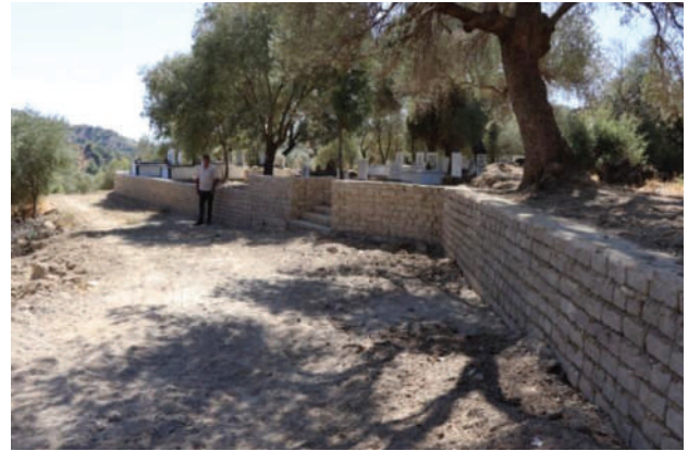
Gedik Mahallesi Mezarlık etrafı istinat duvarı
