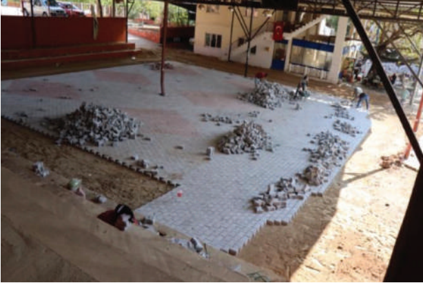
Aksu Mahallesi Sosyal Çatı altı Düzenlemesi
