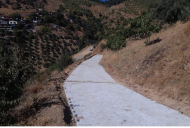
Ketenova Mah. Yol Düzenlemesi
