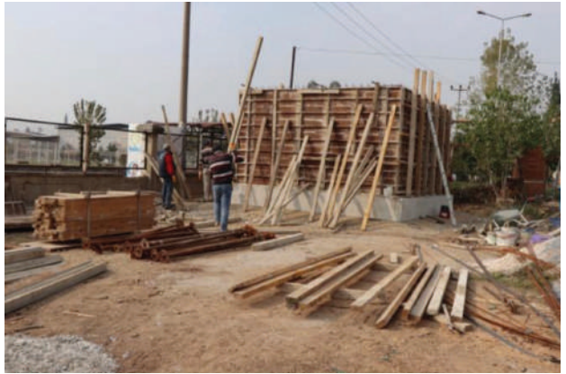
Şantiye Yanı 40 tonluk iyi su deposu yapımı
