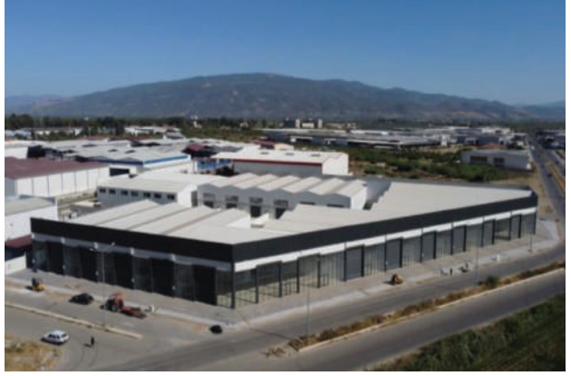
Ticaret Odası dükkanları önü Kaldırım Düzenleme
