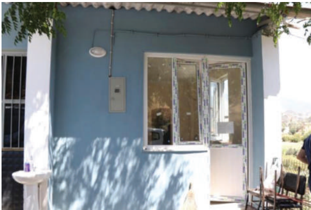
Kardeşköy Muhtarlık Binası yenilendi
