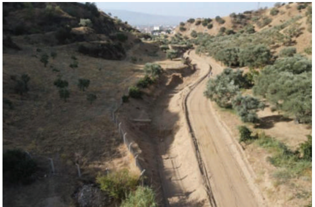
Topandağ Dere Yatağı ıslah çalışmaları
