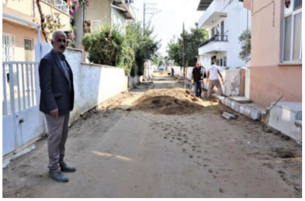
Yeşil Mah. 1143 Sok. Yol düzenlemesi
