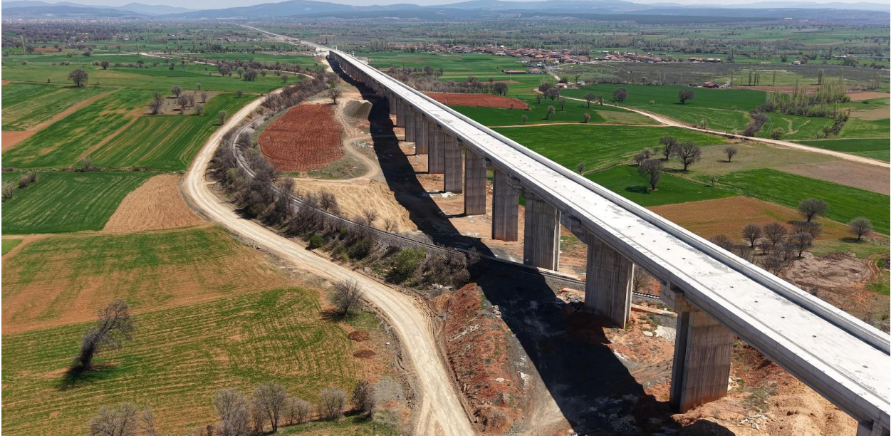
V13 Viyadüğü 1.112 m/ Açıklık Sayısı: 34 m
