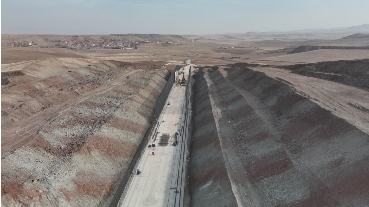
Saha Çalışmaları-Aç-Kapa Km:34+000
