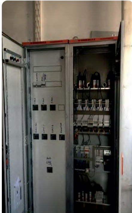
KOM Şube Müdürlüğü hizmet binası 10KVAR kompanze ve dağıtım panosu yenisi ile değiştirilerek sistem devreye alınmıştır.
