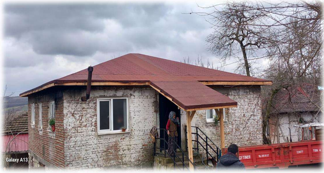
Sepetçi Mahallesi Merkez Cami Önü Sundurma İmalatı Çalışması
