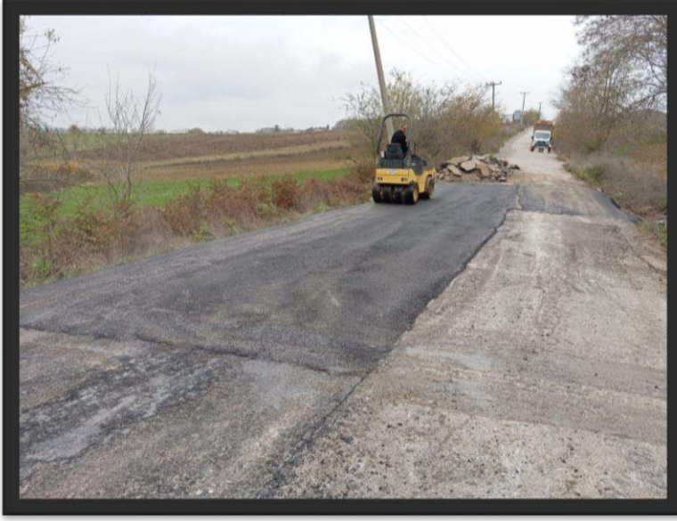
Eğercili Mahallesi Asfalt Bakım Onarım Çalışması
