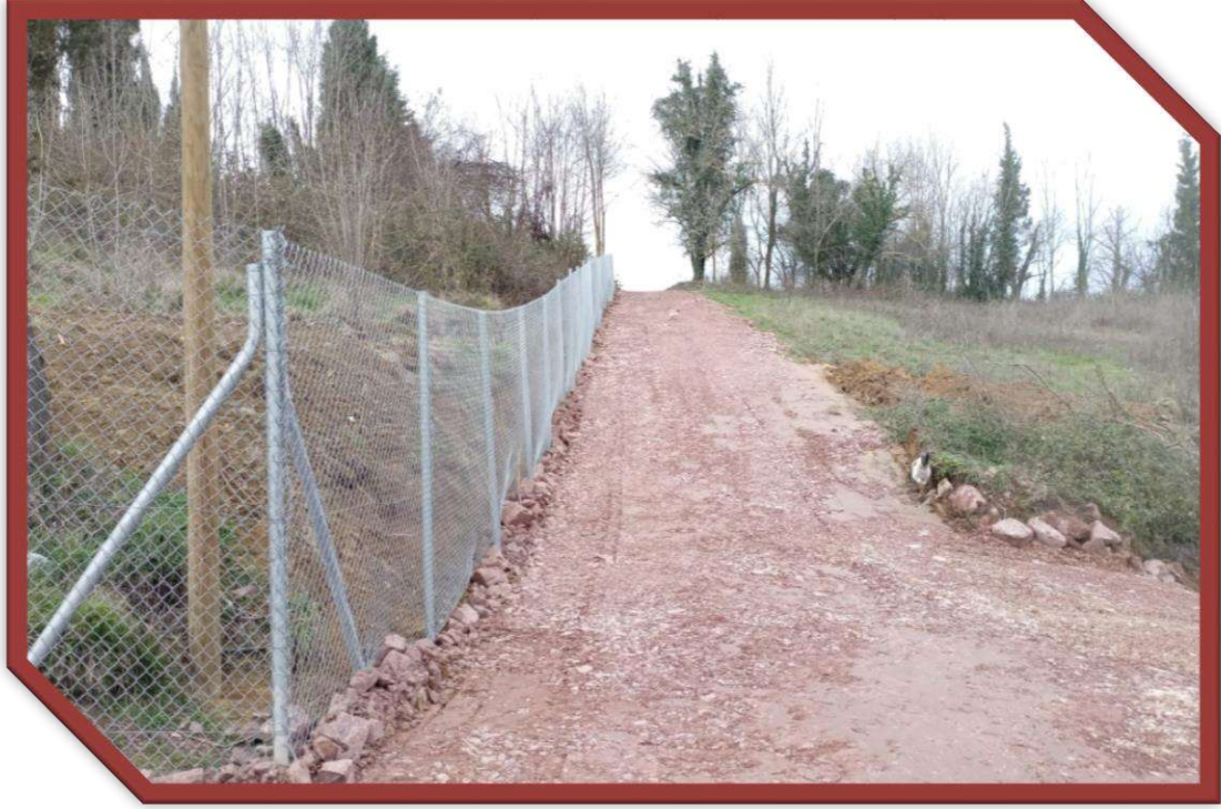
Topluca Mahallesi Stabilize Serim ve Bakım Çalışması
