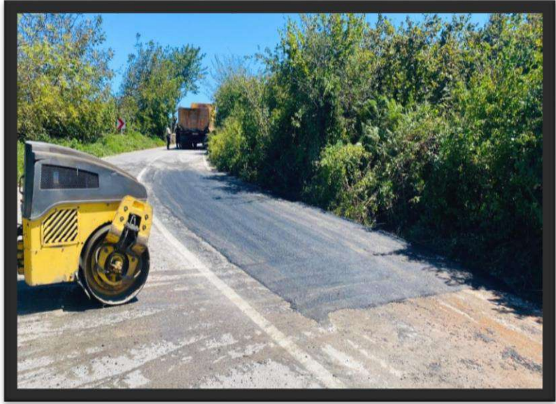
Çerçili Mahallesi Asfalt Bakım Onarım Çalışması
