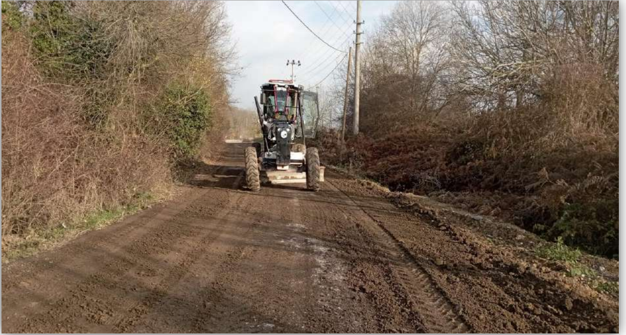
Topluca Mahallesi Arazi Yolu Tesviye Çalışması
