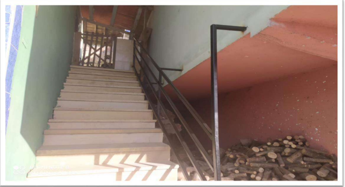
Akıncı Mahallesi İmam Evi Merdiven Korkuluk İmalat Çalışması
