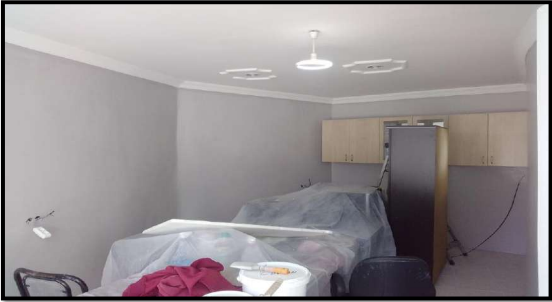
Akçaova Mahallesi Muhtarlık Binası İç Ve Dış Cephe Boyama Çalışması
