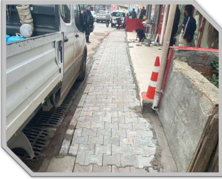
Carşı Mahallesi Parke İmalat Çalışması
