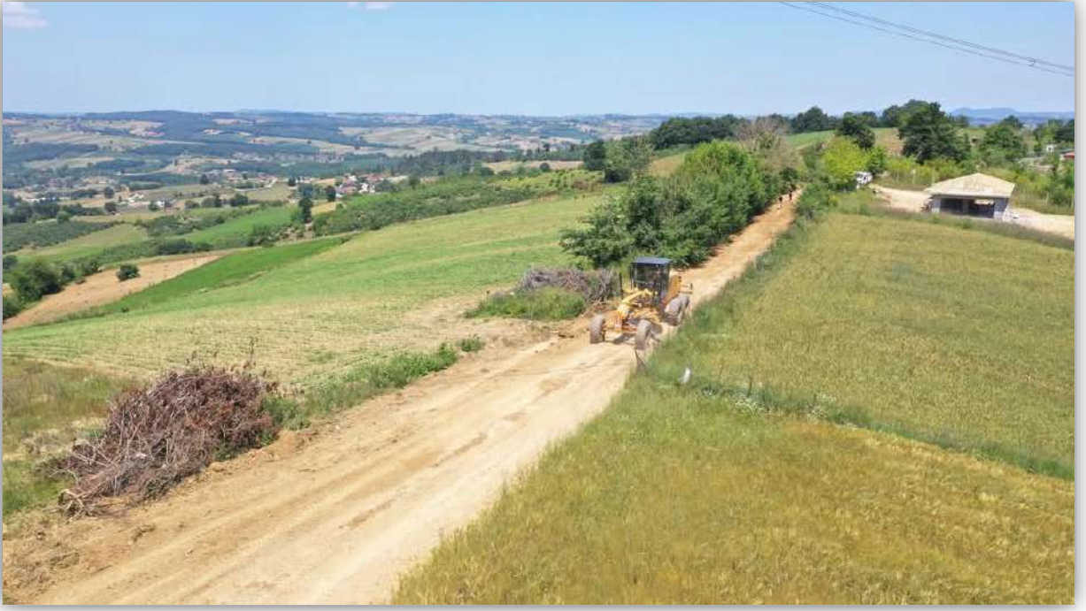
Sarıahmetler Mahallesi Tesviye Çalışması
