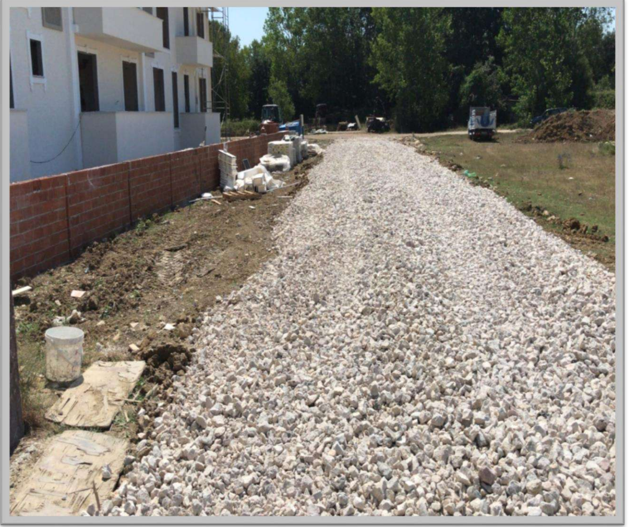
Orhan Mahallesi Malzeme Serim Çalışması
