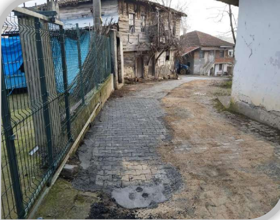
Hacılar Mahallesi Parke İmalat Çalışması
