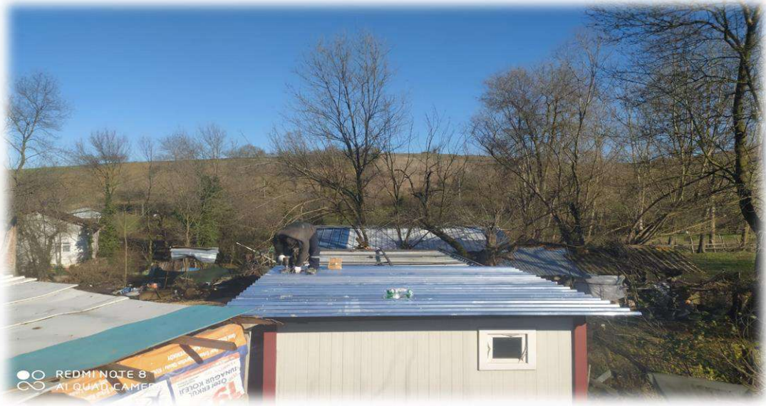
Yanan Ev Yanındaki Konteyner Üstü Çatı İmalat Çalışması
