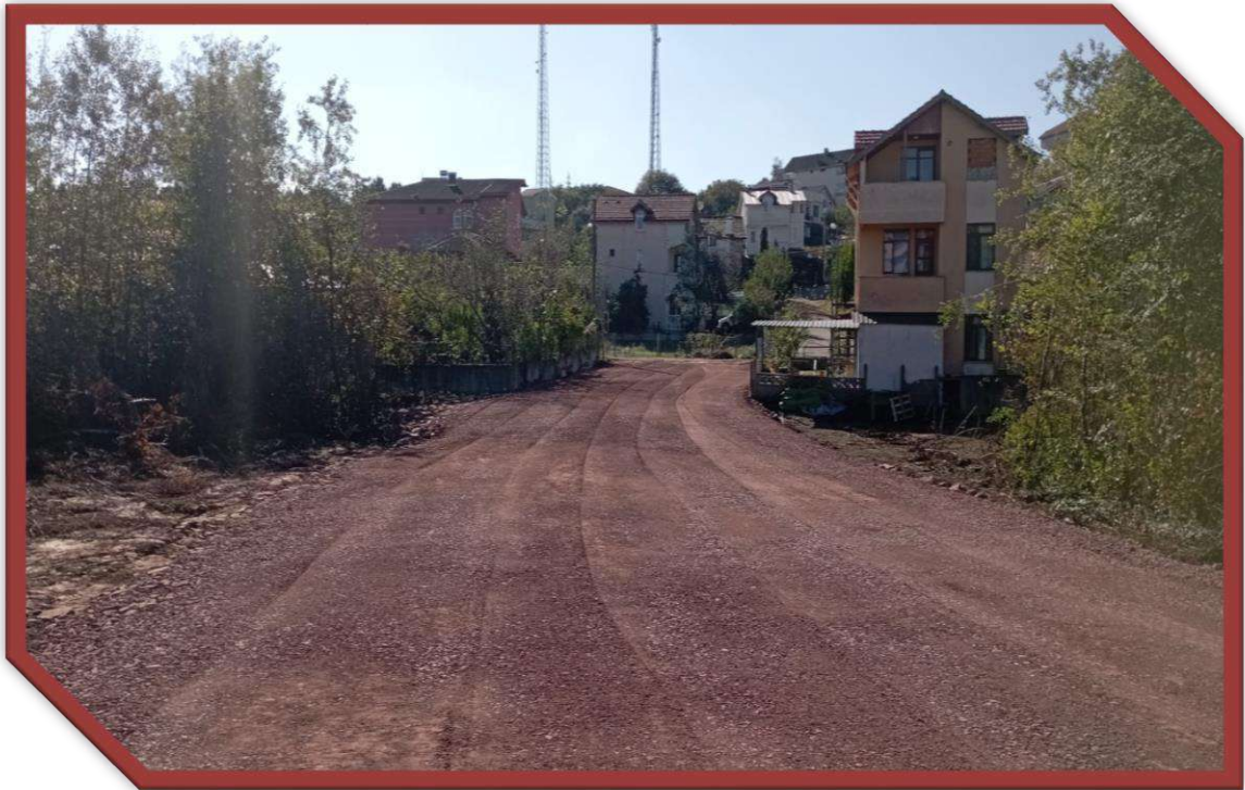
Kefken Mahallesi Stabilize Serim ve Bakım Çalışması
