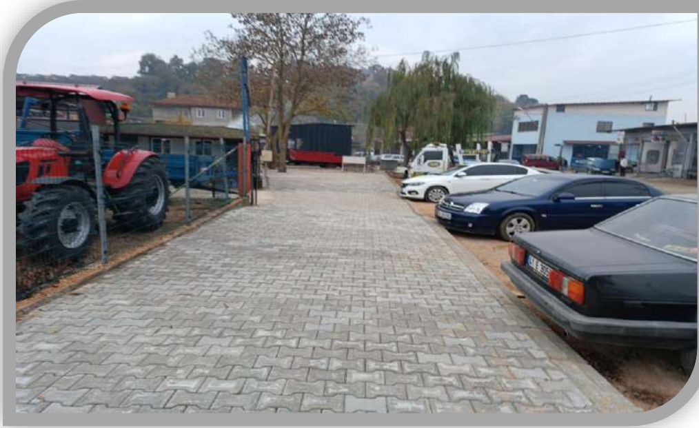
Çarşı Mahallesi Parke İmalat Çalışması
