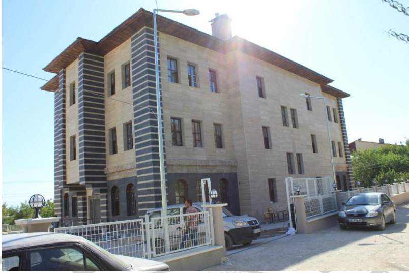
Resim 3- Adilcevaz İlçe Emniyet Müdürlüğü Binası
