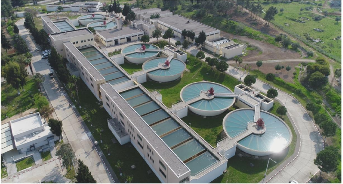
Tarsus Berdan İçme Suyu Arıtma Tesisı
