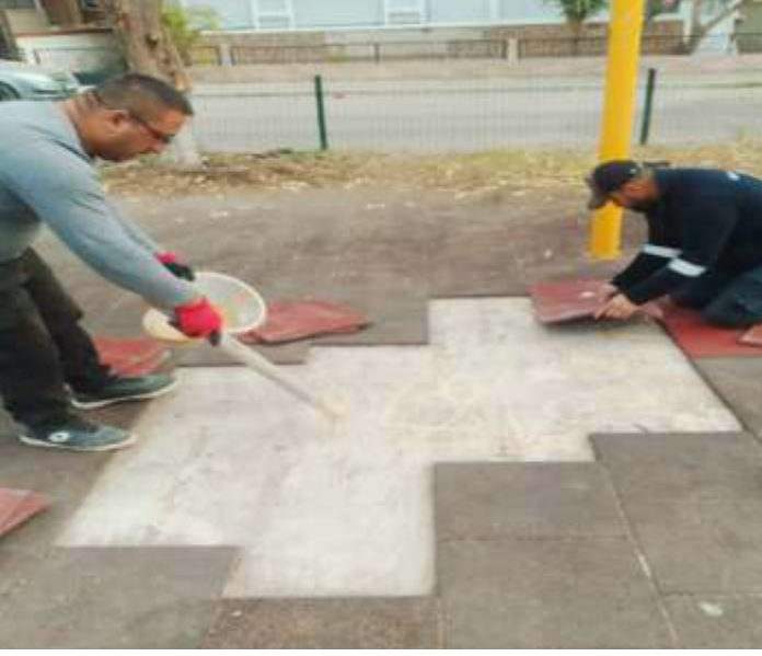
İlçemiz geneli park alanlarımızda kauçuk tamirâtı işlemleri yapılmıştır.
