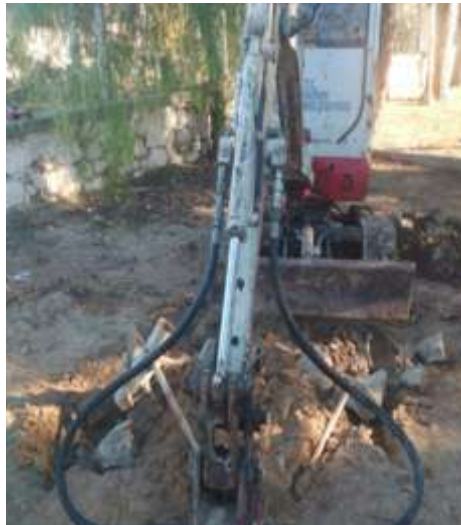
Mini ekskavatör kepçesi su arızası çalışmalarında kullanılmıştır.
