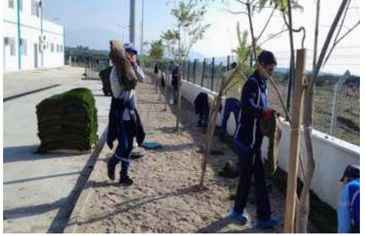
Mama Fabrikası Binasının bulunduğu bahçeye hazır çim uygulama çalışmaları yapılmıştır.
