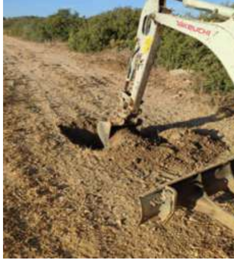
Mini ekskavatör kepçe ile ağaç fidan dikim için 700 fidan çukur açma işlemi yapılmıştır.
