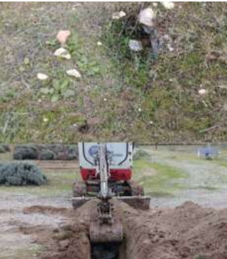
Mini ekskavatör kepçesi su arızası çalışmalarında kullanılmıştır.
