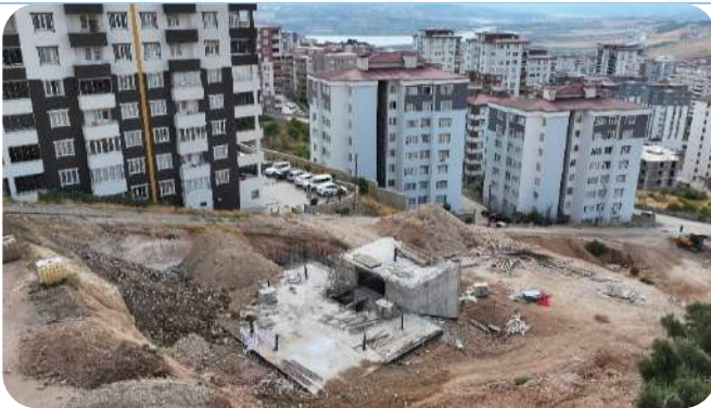
Merkez İçmesuyu, Kanalizasyon ve Yağmursuyu İnşaatı Çalışmaları Devam Ediyor
