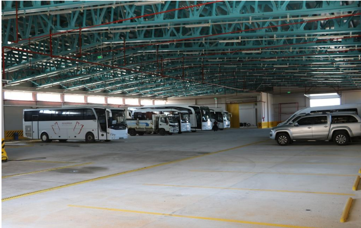
Resim 4. Hangar İç Görünüm
