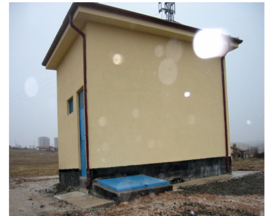
Çarıklar 5000 m 3 'lük Gömme Su Deposu İşinde Terfi Merkezi Binası
