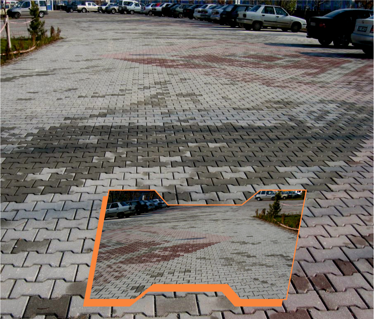
Tesislerimizin beton bordür ve beton parke işleri ekiplerimizce yapılmıştır.
