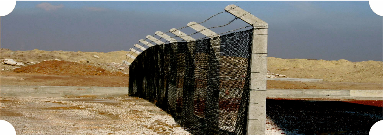
Tatlısu kaynakları ve Altınapa Barajı çevresi koruma amaçlı tel örgünün tamir ve bakım işleri yapılmıştır.
