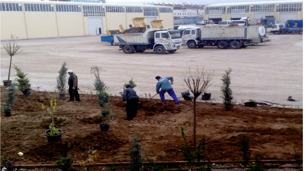
Selçuklu ve Arif Bilge Tesislerinin çevresine toprak tesviyesi, fidan dikimi ve sulama işleri yapılmıştır.
