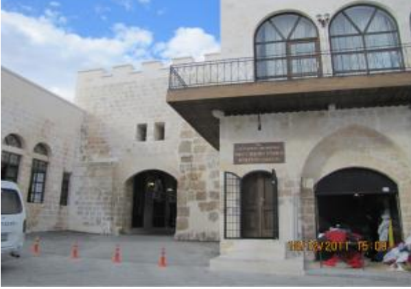
Harran Kapı Doğu Batı Yönündeki Yapıların Restorasyon İşi Tamamlanmıştır
