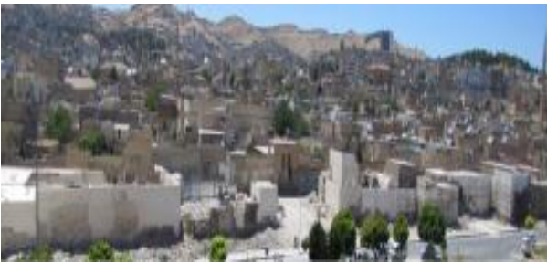
Bedendibi Surları Restorasyon Projesi
