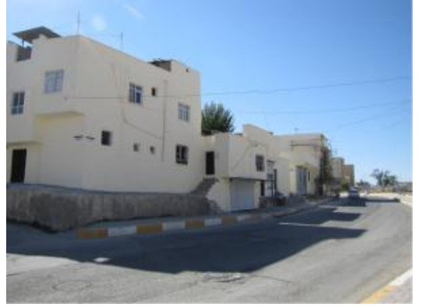
Fuar Caddesinde Cephe Sağıklaştırma Çalışması Tamamlandı
