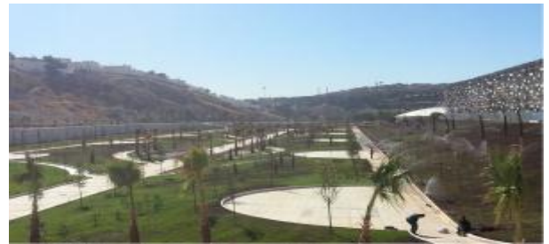
Halepli Bahçe Park Alanı Yapım İşİ Tamamlandı.
