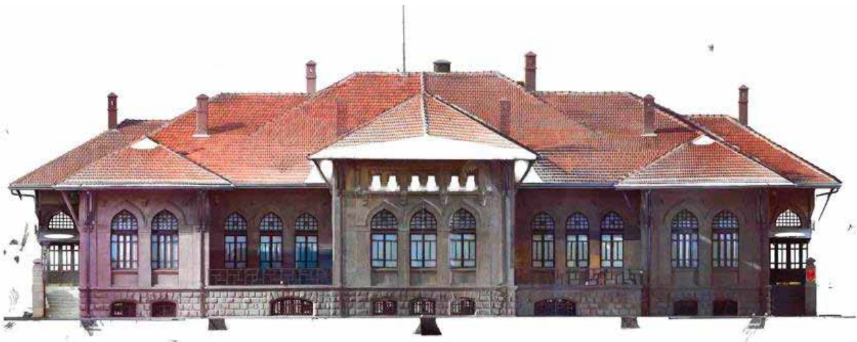
1. TBMM Binası (Kurtuluş Savaşı Müzesi) Fotogrametrik Rölövesi, Güneydoğu Cephesi, 3 boyutlu lazer tarayıcı ile yapılan ölçüm.
