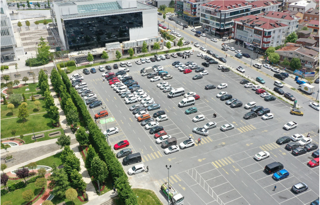
Yönetim Merkezi Binası Açık Otoparkı, 2024
