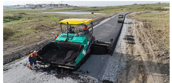
Asfalt Kaplama Çalışmaları, Yassiören Mahallesi Hayvan Barınağı Yolu, 2024
