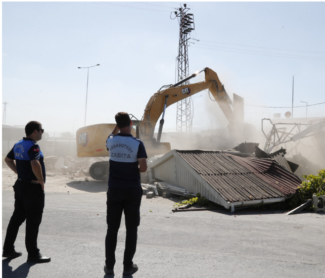
Yıkım Kararının Uygulanması, 2024
