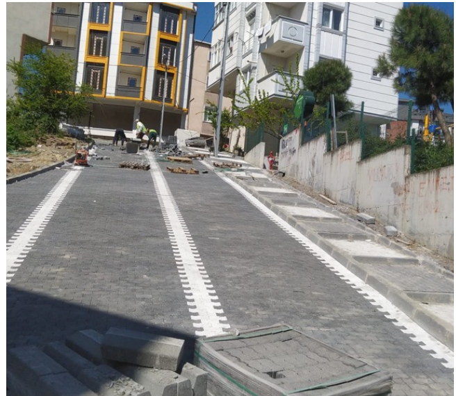
Beycan Sokak Tretuvar Çalışması, İslambey Mahallesi, 2024
