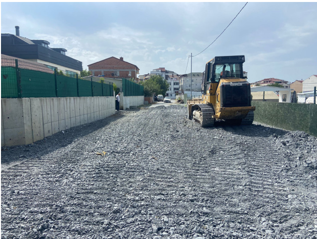
Stabilize Serilmesi, Selvilik Sokak, Mavigöl Mahallesi, 2024
