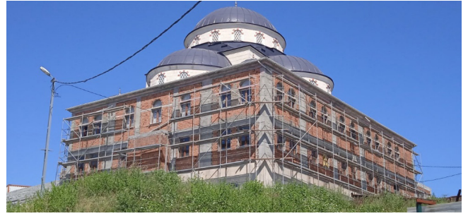
Taşoluk Yıldırım Beyazıt Camii Dış Cephe Kaplama ve Boyama Çalışması, 2024
