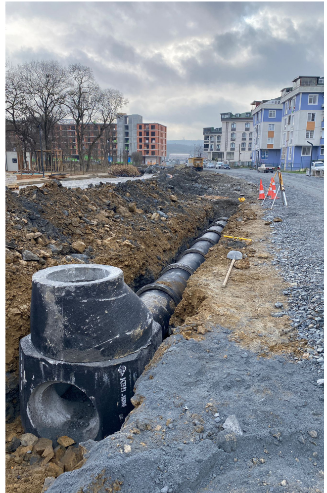
Yağmursuyu Altyapı Çalışmaları, Ulubatlı Hasan Caddesi, Hicret Mahallesi, 2024
