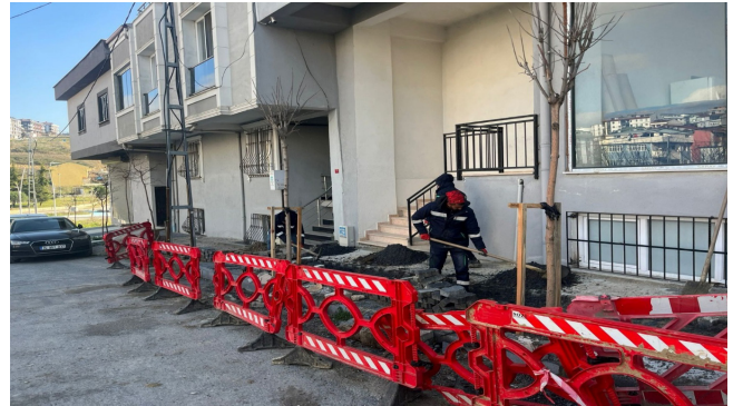
Altyapı Kazı Ruhsatı Çalışmaları, 2024
