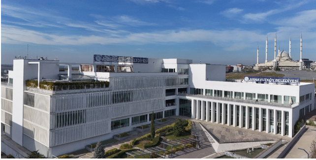
Arnavutköy Belediyesi Ana Hizmet ve Meclis Binası, 2024
