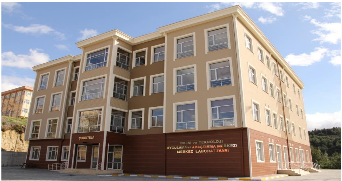
Merkezi Araştırma Laboratuvar Binası
