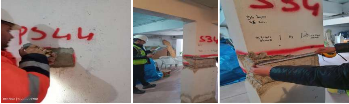
Yerinde yapılan ölçüm ve incelemeler
