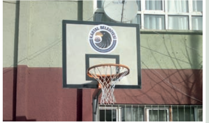
Yakacık Yeni Mahallesi Hesna Gündüş İlköğretim Okulu Basketbol Potası Kurulumu
