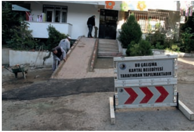
Çarşı Mahallesi Hamam Sokak Bina Girişi Engelli Vatandaşlar İçin Rampa Yapımı
