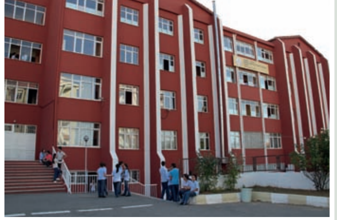
Atalar Mahallesi Kartal Anadolu Ticaret Meslek ve Ticaret Meslek Lisesi Bina Dış Cephe Boyama Çalışması
