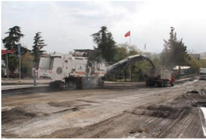
Esentepe Mahallesi Anadolu Sokak Asfalt Kazma Çalışması
