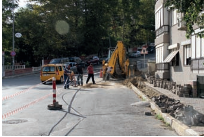
Kordonboyu Mahallesi Neyzen Tevfik Caddesi Aydınlatma Kabloların Yeraltına Direk Yerleştirme Çalışmaları
