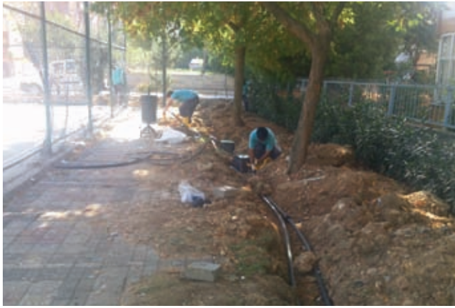
Orhantepe Mahallesi Kumral Sokak Şerafettin Özer Parkı Otomatik Sulama Tesisatı Kurulumu
