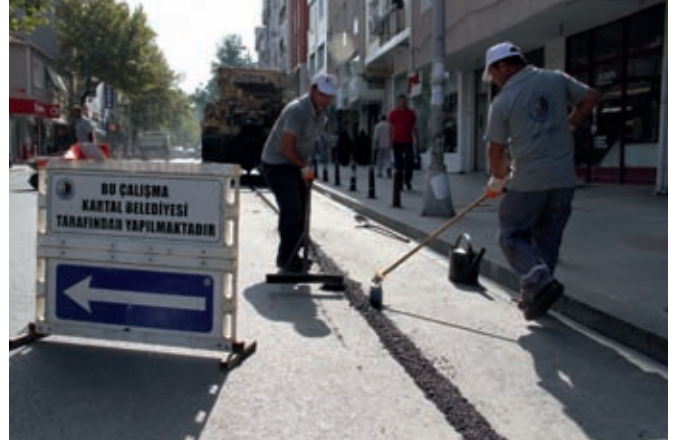
Soğanlık Yeni Mahallesi Atatürk Caddesi Fiberoptik Alınması Çalışması Sonrası Asfalt Dolgu Yapımı
