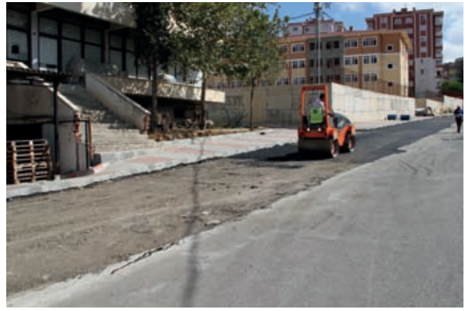
Hürriyet Mahallesi Gazanfer Bilge Sokak Asfalt Yama Çalışması
