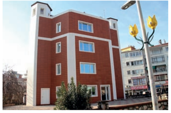
Soğanlık Polis Merkezi Binası
