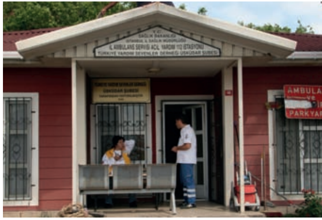
Cevizli Mahallesi 112 Acil Yardım İstasyonu
