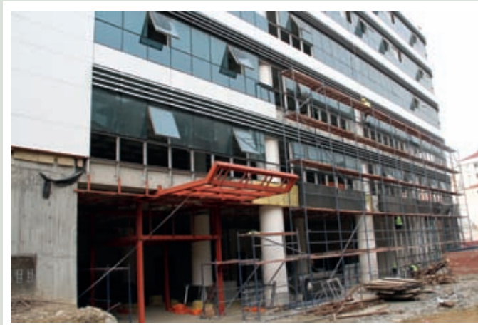
Yukarı Mahallesi Çırçır Caddesi Yeni Belediye Hizmet Binası Yapımı
