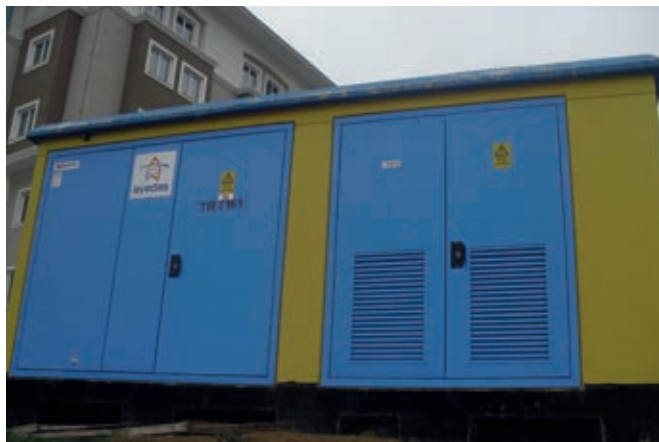
Esentepe Mahallesi Pamuk Sokak Trafo Kurulum Çalışması
