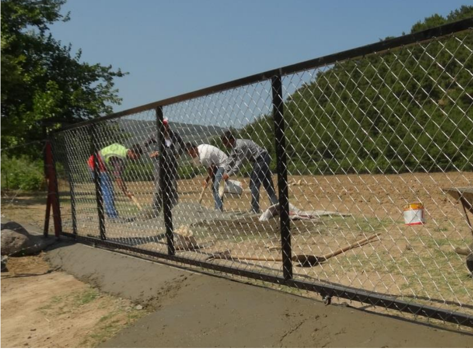
Şekil 8. Arazimizin etrafının çit ile çevirme işinden görünüm
