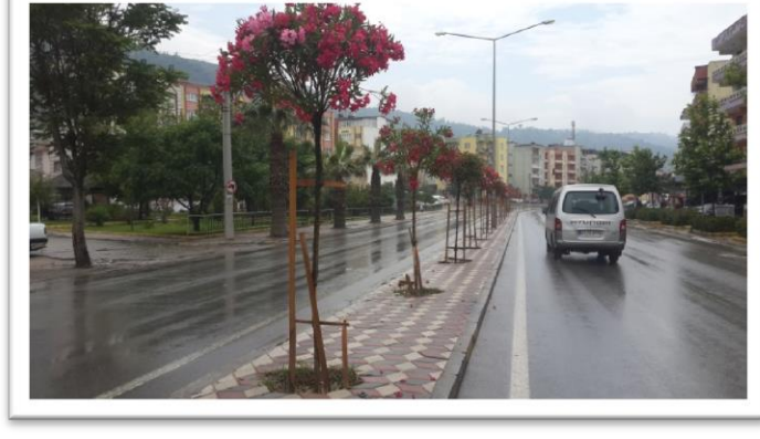
Görüntü 34. Gaziosmanpaşa Caddesi Orta Refüjü Tijli Zakkum Ağacı Dikim Çalışmaları
