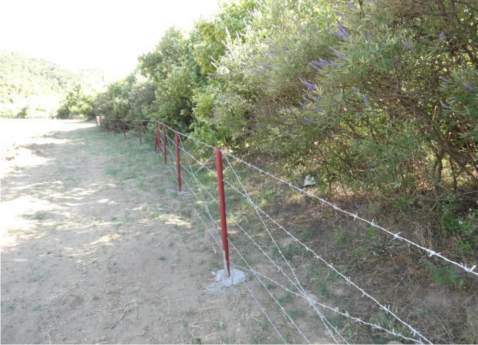
Şekil 9. Arazimizin etrafının çit ile çevirme işinden görünüm
