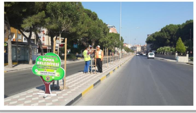
Görüntü 33. Gaziosmanpaşa Caddesi Orta Refüjü Tijli Zakkum Ağacı Dikim Çalışmaları
