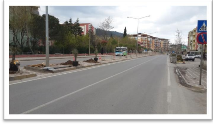
Görüntü 32. Gaziosmanpaşa Caddesi Orta Refüjü Tijli Zakkum Ağacı Dikim Çalışmaları
