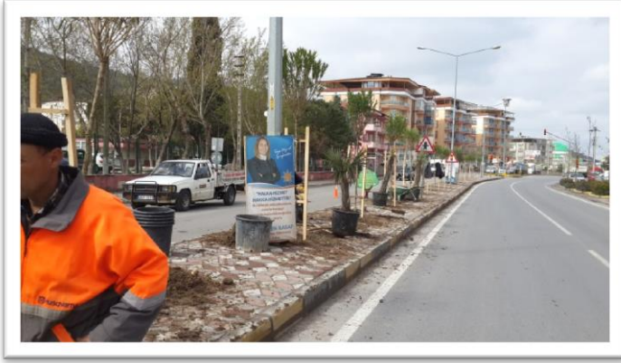
Görüntü 31. Gaziosmanpaşa Caddesi Orta Refüjü Tijli Zakkum Ağacı Dikim Çalışmaları
