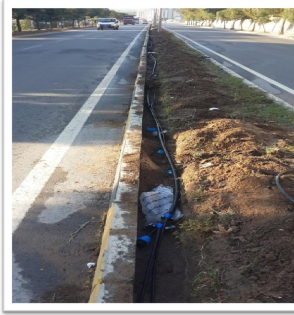
Görüntü 45. Gaziosmanpaşa Caddesi Orta Refüj Otomatik Sulama Sistemi Kurulum Çalışmaları
