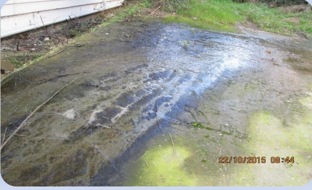
Kaledere Mahallesi Büyük hamza Sokakta Bulunan Ali DURAN'a ait kanalizasyon sokağa akan kanalizasyon kaçıkları tespiti yapılmış olup bina sahibine boru döşettirilerek problem çözüme kavuşturulmuştur
