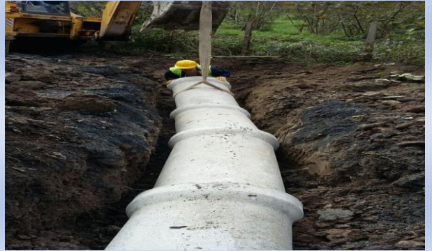
Yağmur Suyu Hattı ve Alt Yapı Çalışmaları
