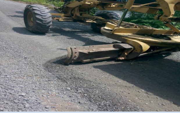
Kırsal Mahallelerde Filler Malzeme, Tüvanan Malzeme Serme Çalışmaları
