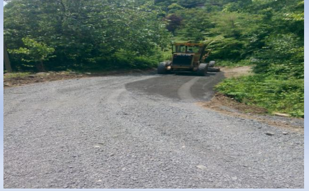
Kırsal Mahallelerde Filler Malzeme, Tüvanan Malzeme Serme Çalışmaları
