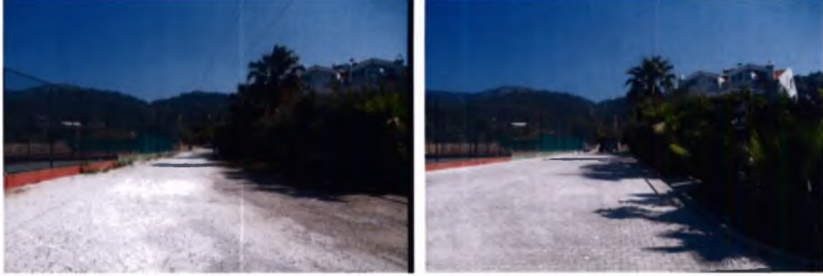
ARMUTALAN MAHALLESİ 537. SOKAK PARKE YOL ÇALIŞMASI
