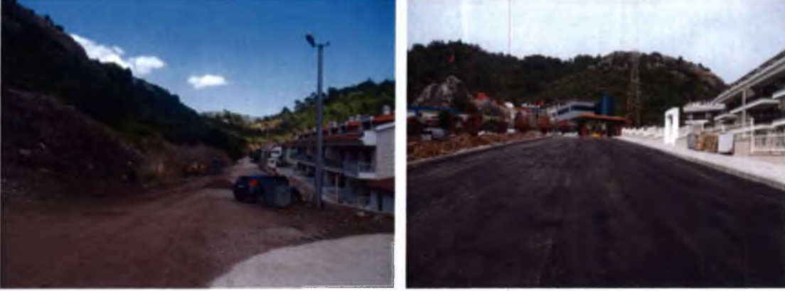
ARMUTALAN MAHALLESİ ÇAVDAR BOYU CAD.(UZUNLUK 40 METRE TOPLAMDA 680 M2)
