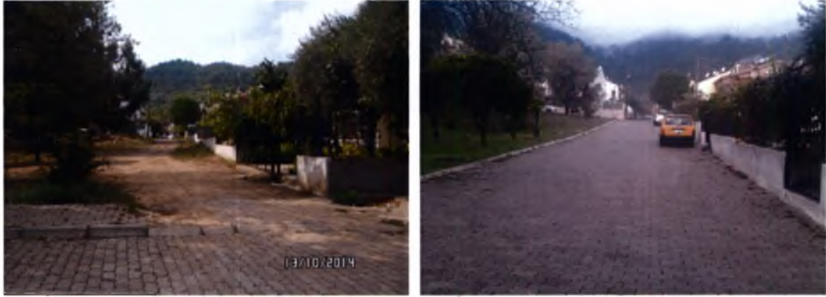
ARMUTALAN MAHALLESİ 417. SOK PARKE YOL YAPIMI
