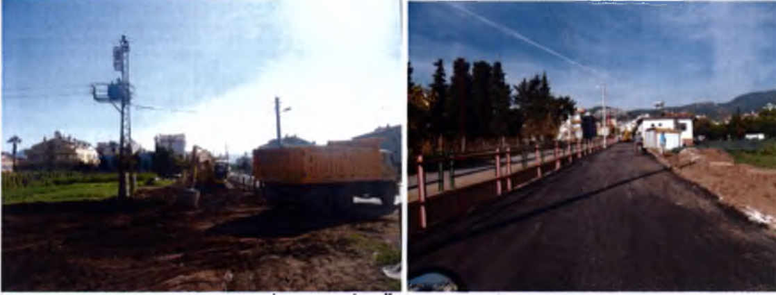
ARMUTALAN MAHALLESİ HAMDİ YÜZAK CAD., 519, 526 SOKAKLAR ROTMİKS ASFALT YOL ÇALIŞMASI ( UZUNLUK 348 METRE 2 BİN 784 M2)
