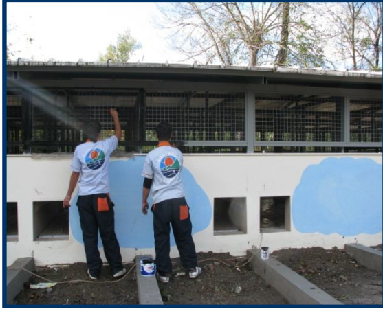
Siteler mahallesi 1318 sok. / 1319 sokak kesişimi park yapım çalışmaları
