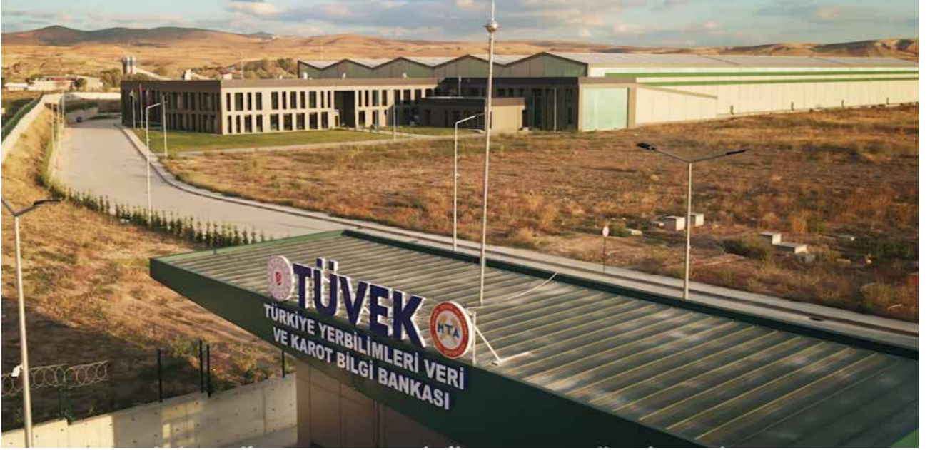
TÜVEK Hizmet Binası
