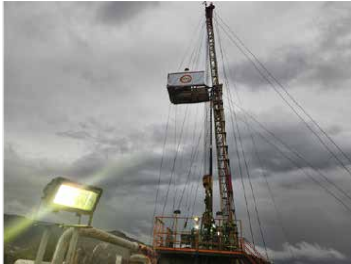
İzmir ili sondaj çalışmalarından görünüm
