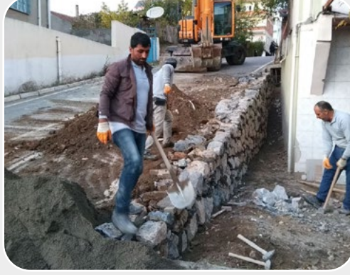
İstinat Duvar Yapım İşi
