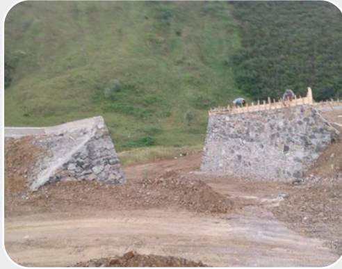
İstinat Duvar Yapım İşi
