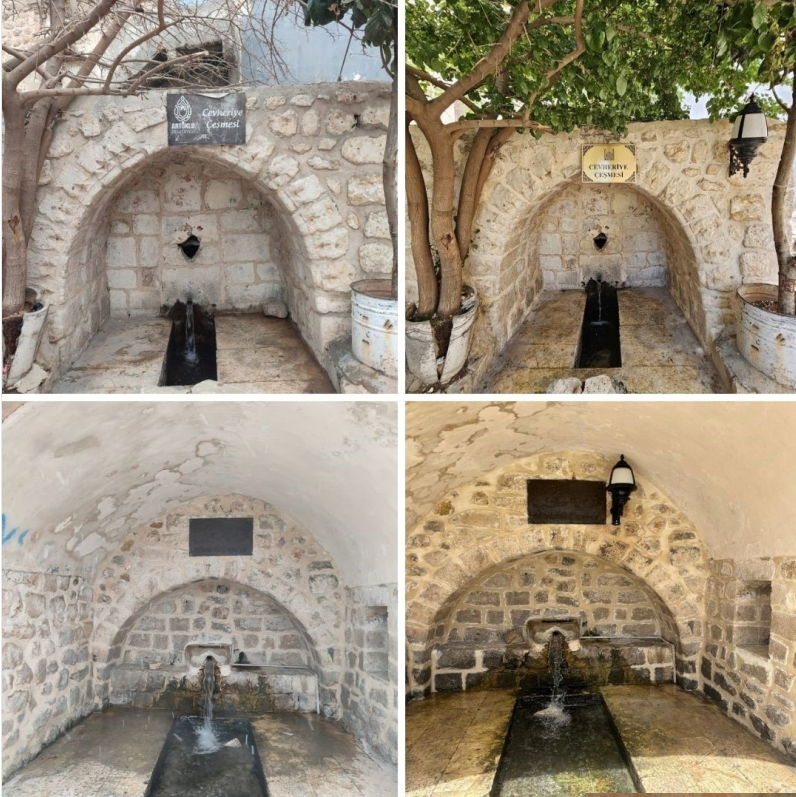
Tarihi Çeşmelerin Bakım ve Onarımı
