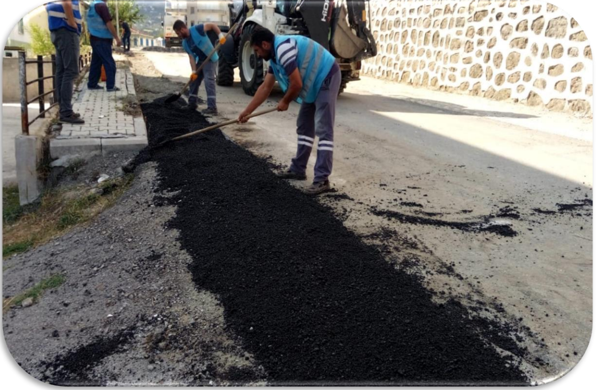
Toptepe Mah. – Bayırlı Sokak’ ta asfalt onarım çalışmaları
