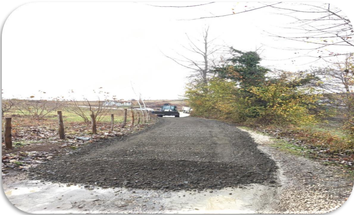
Fen İşleri Müdürlüğü tarafından temel yol (mıcır) malzemesi serim işlemleri
