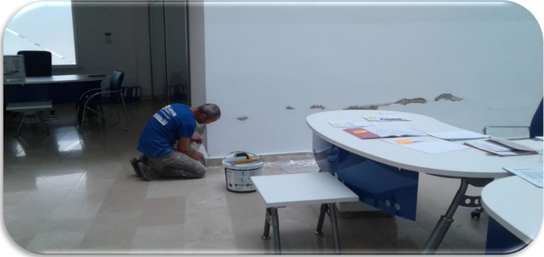
Belediye ana hizmet binası bakım onarım alışmaları
