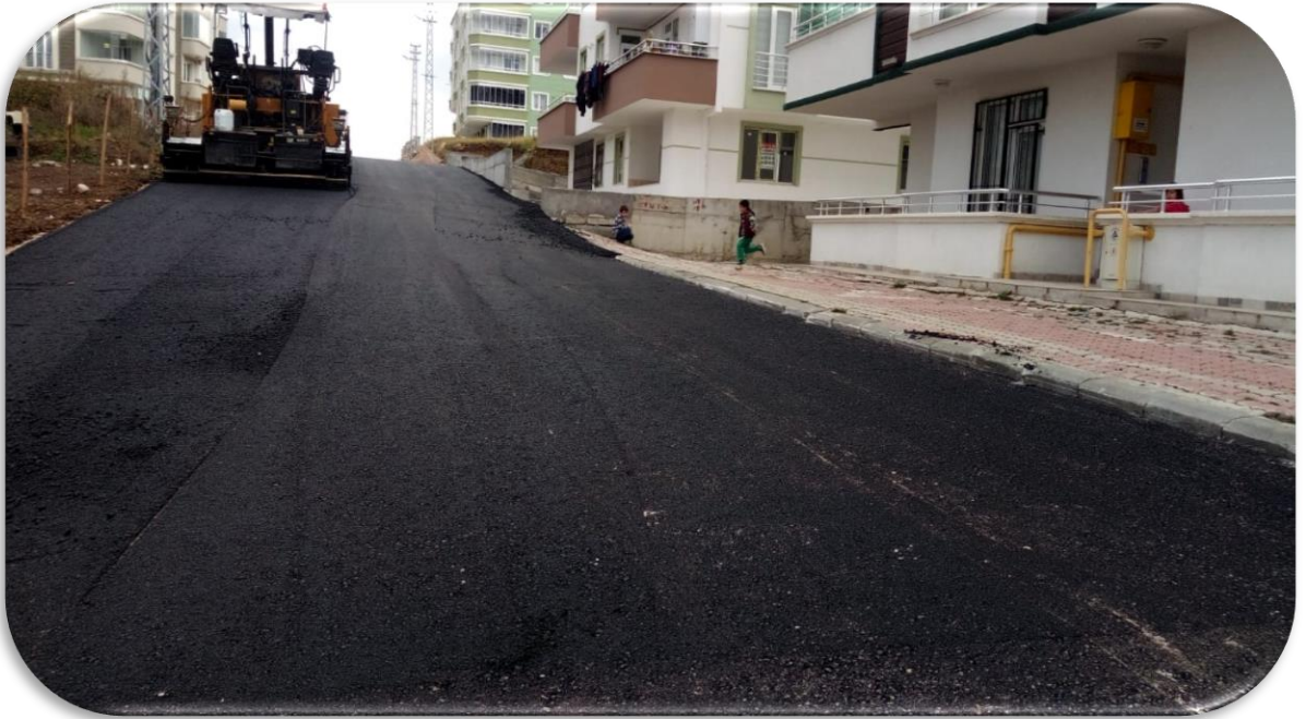
İlçemiz muhtelif sokaklarda yapılan asfalt serim çalışmaları
