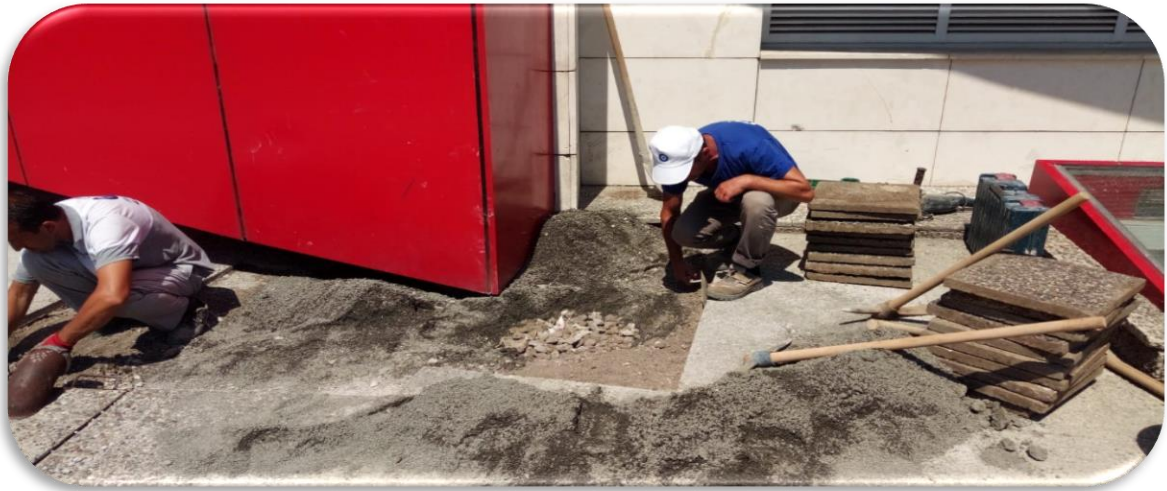
Belediye ana hizmet binası bakım onarım alışmaları
