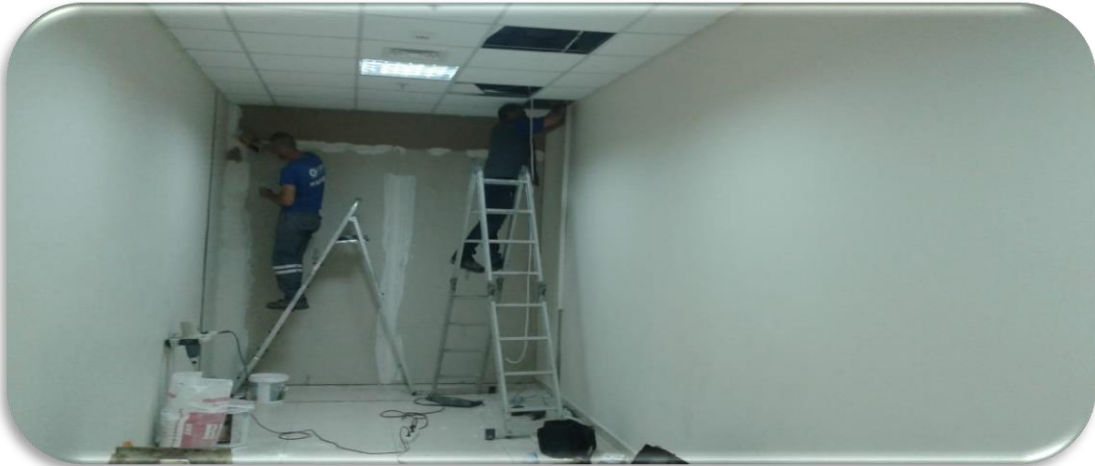
Canik Kültür Merkezi bakım ve onarım çalışmaları
