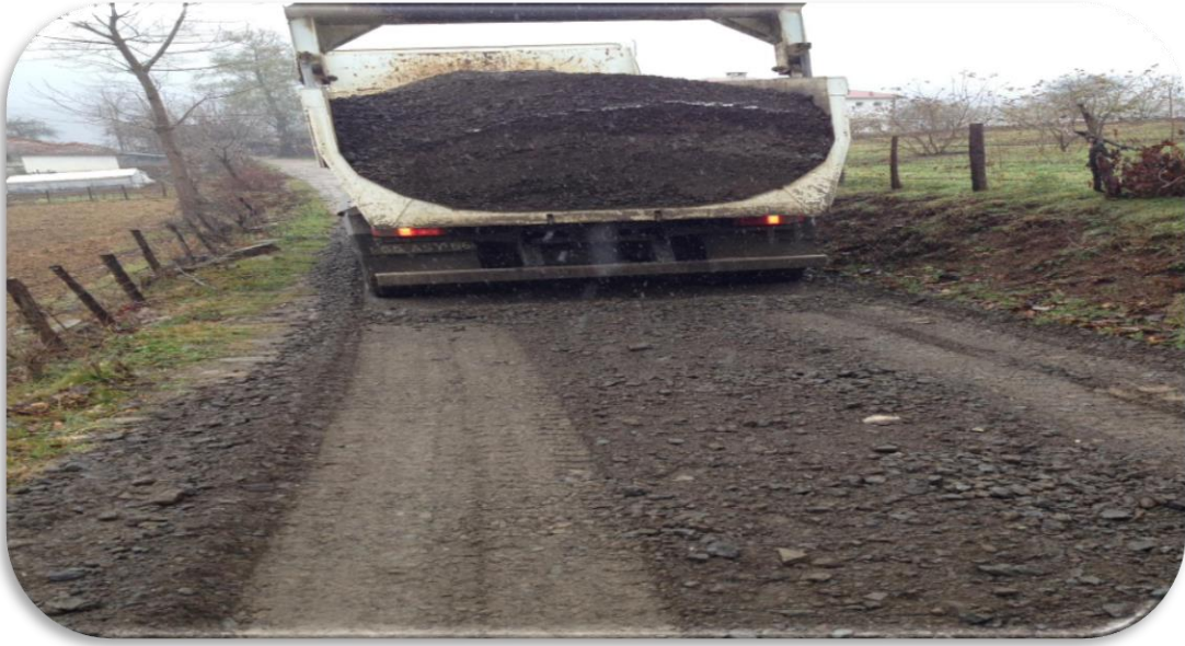
Fen İşleri Müdürlüğü tarafından temel yol (mıcır) malzemesi serim işlemleri
