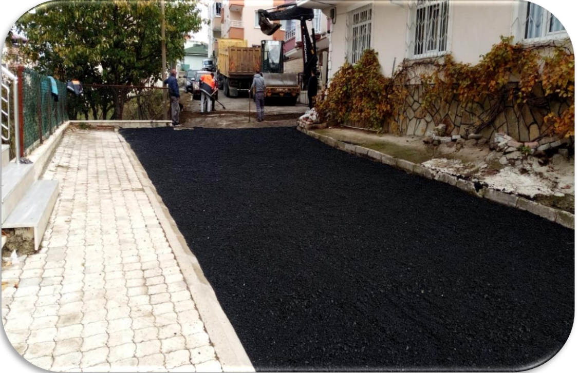
Asfalt serim çalışmaları
