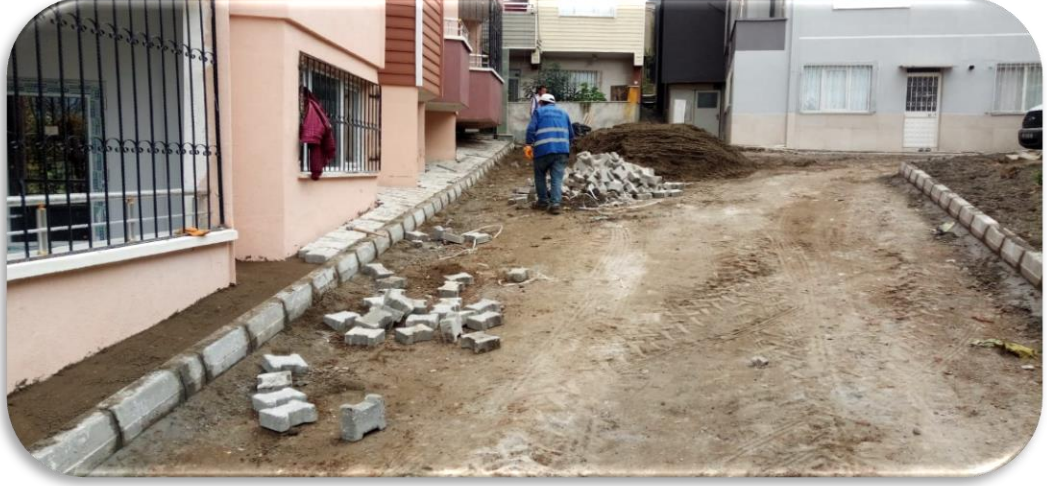
Muhtelif mahallelerimizde parke yol yapım ve onarım çalışmaları
