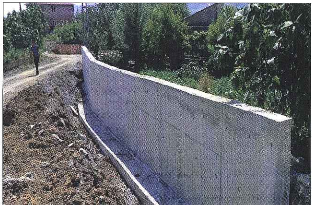
Tepecik Mh.1571 Sk. Betonarme Perde Duvar Yapımı
