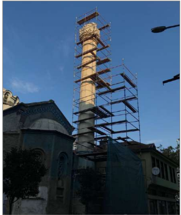
Balıkpazarı Camii minare yıkım işi
