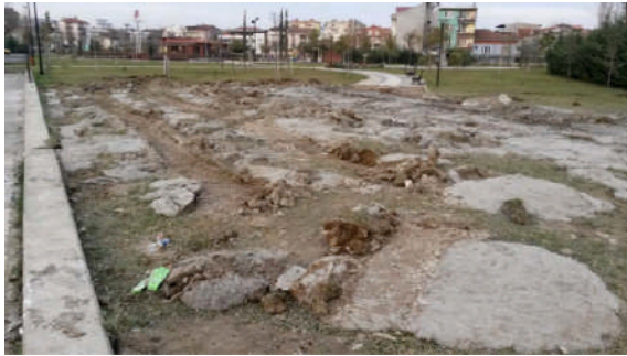
Bölge Parkı yanı sağlık ocağı projesine ait Jet-Grout Zemin iyileştirme Yöntemi Uygulaması
