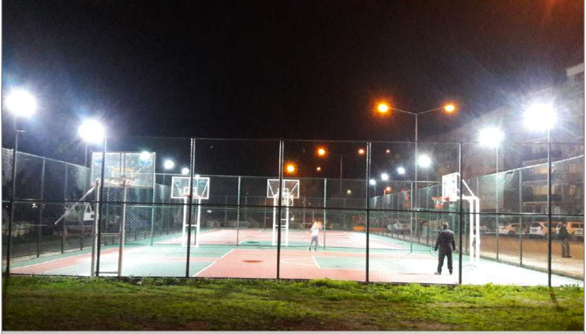
Kayıkhanne Mevkii basketbol sahası aydınlatma işi
