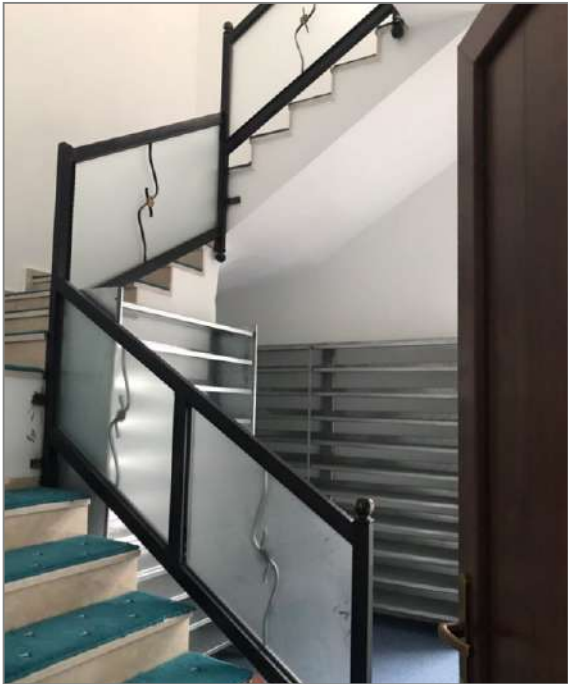
Ayşe Hatun Camii iç korkuluk yapım işi
