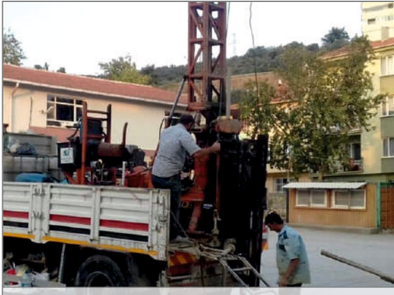
Şehit Cemal Okulu yeni bina sondaj çalışması
