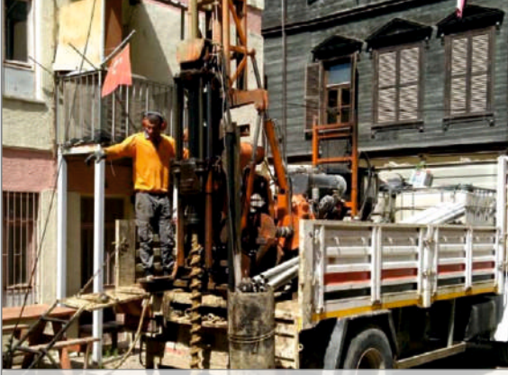
Balıkpazarı Sağlık Ocağı Sondaj Çalışması
