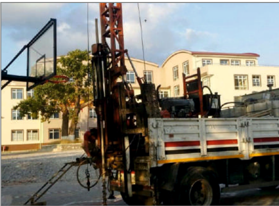
Gemlik Lisesi Kapalı Spor Salonu Sondaj Çalışması
