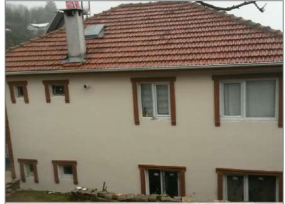
Güvenli Camii Müştemilatı yapım işi
