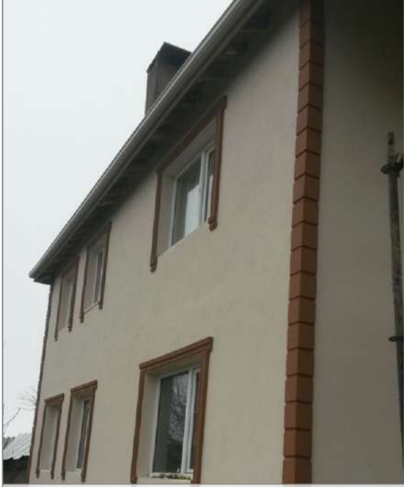
Güvenli Camii müştemilatı yapım işi
