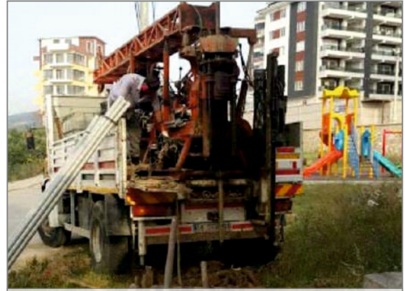
Hisar Mah. Sağlık Ocağı Sondaj Çalışması
