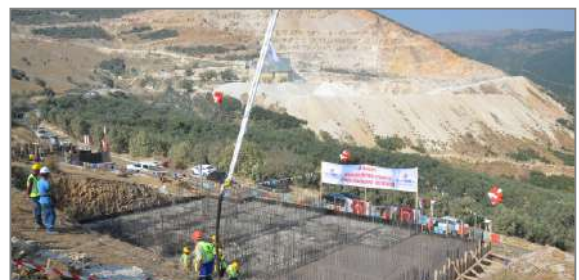
Cihatlı Toplu Konutları 4. Etap Temel Atma Töreni
