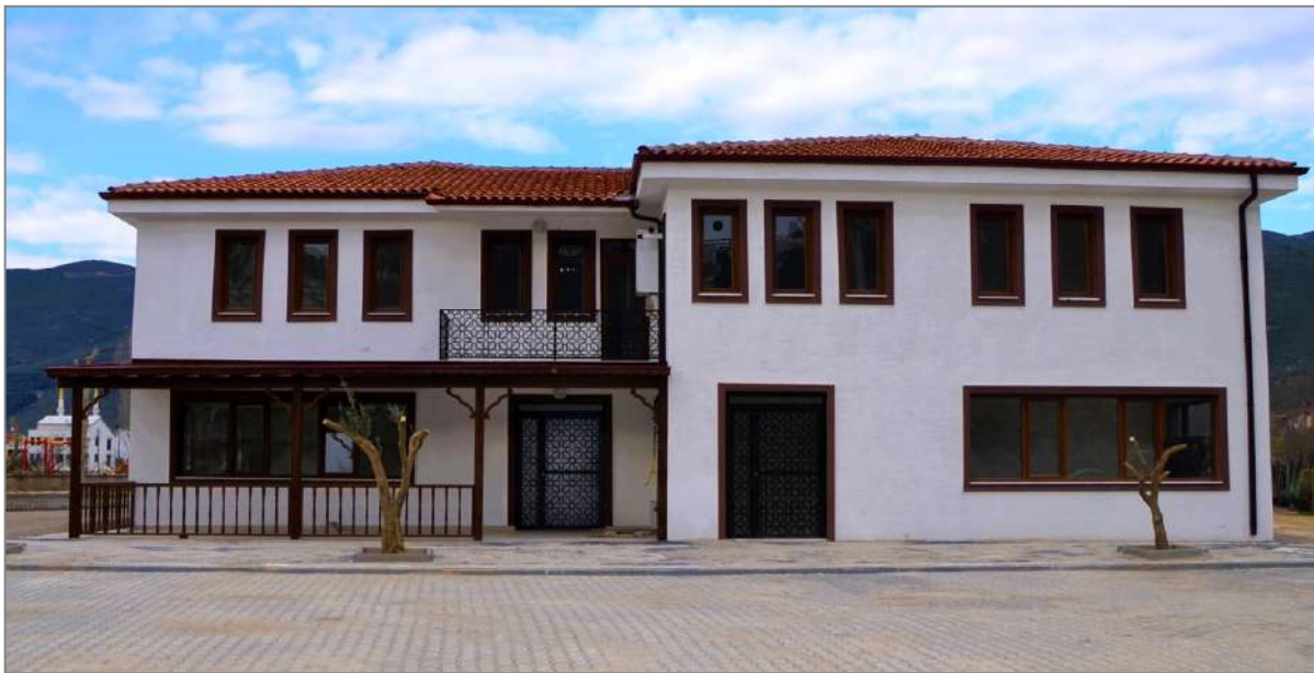
Ziraat Odası binası inşa edilerek hemşehrilerimizin hizmetine sunuldu.
