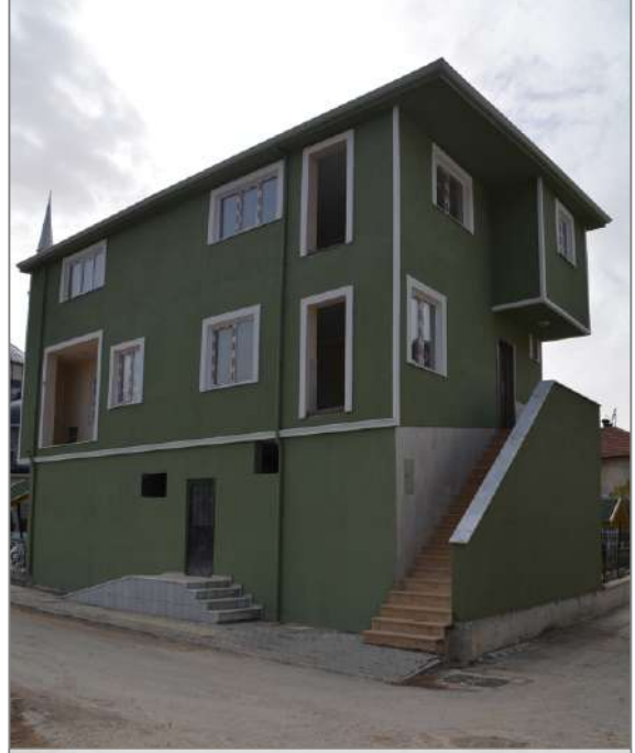
Mevlana Camii müştemilatı yapım işi
