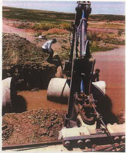
2- Sinan Mahallesiinde 16metre Q1000 buz boru alışması yapıldı.
