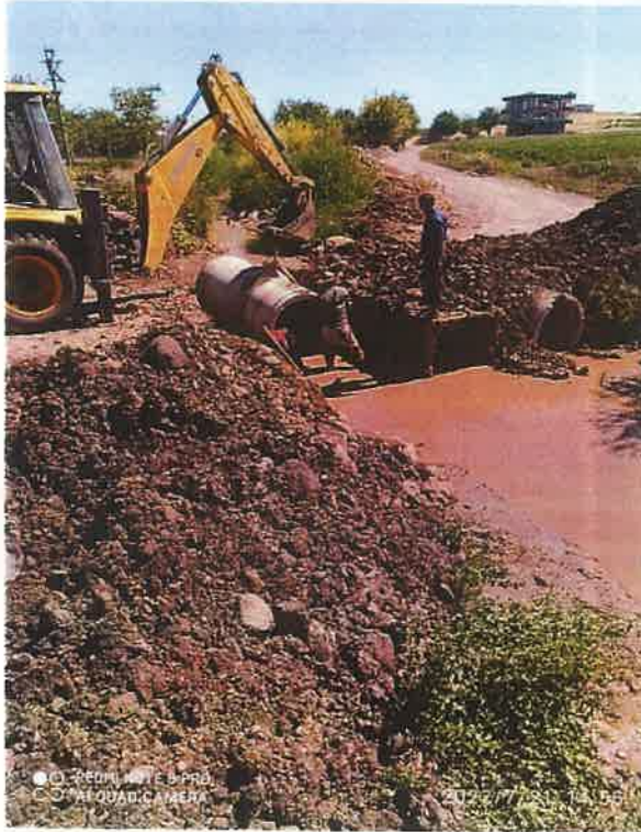
4- Kurudere Mahallesinde 16metre Q1000 buz boru çalışması yapıldı.
