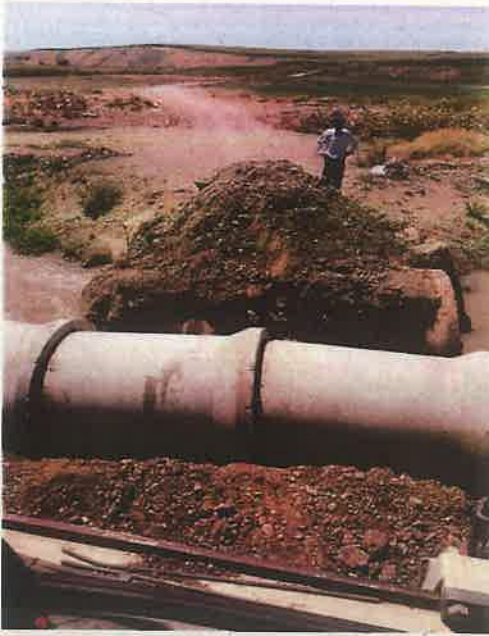
2- Sinan Mahallesiinde 16metre Q1000 buz boru alışması yapıldı.
