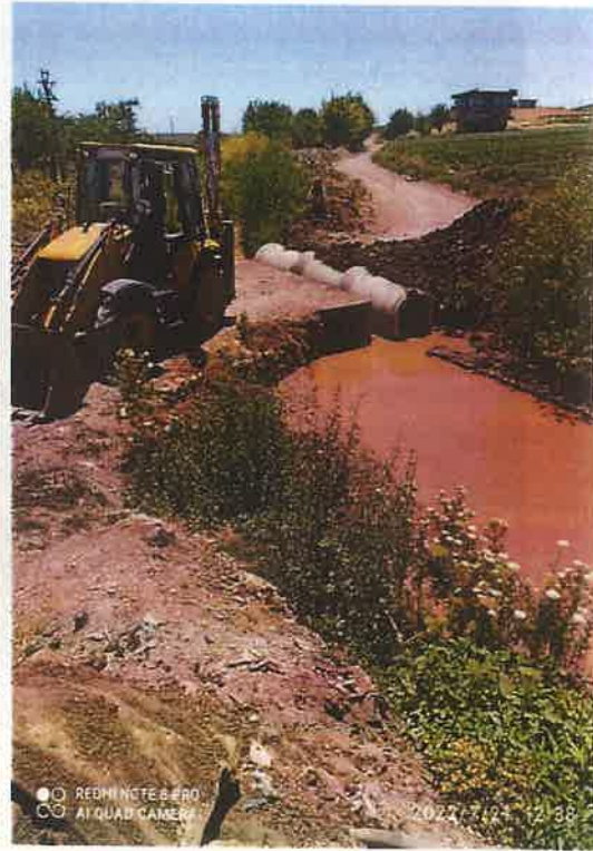
4- Kurudere Mahallesinde 16metre Q1000 buz boru çalışması yapıldı.
