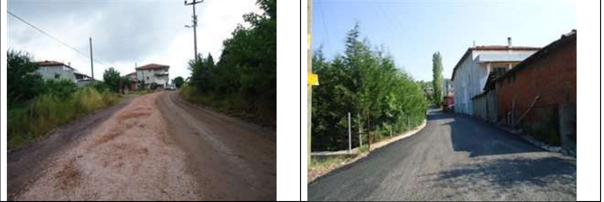
Eşme, Bağdat Caddesi, Asfalt serim çalışması tamamlandı. 1500 mt uzunluğunda 10 mt genişliğinde 3050 ton asfalt serildi.
