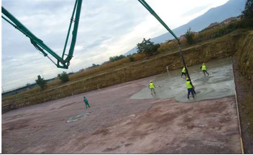
Hürriyet mah İmam Hatip Lisesi temel dolgu çalışması 1500 m2 alanda 4 mt kazı yapıp 2.5 mt dolgu için 5000 ton mekanik malzeme çekildi
