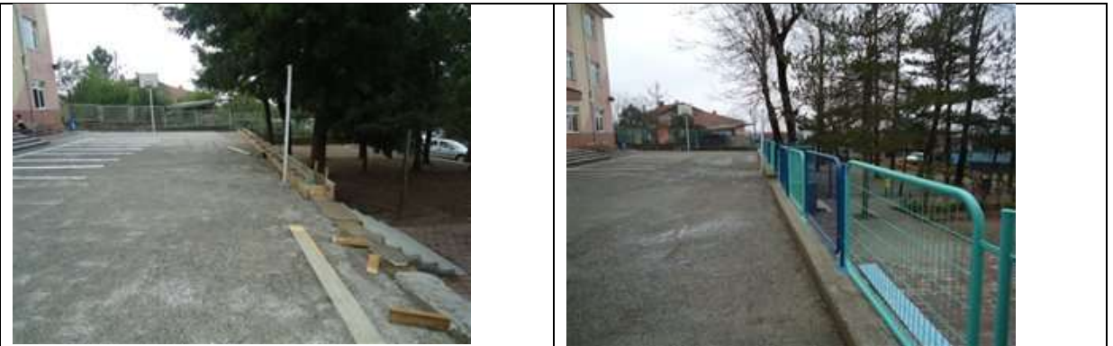
Arslanbey Şevkatiye mahallesi İlköğretim Okulu Korkuluk Yapımı.
