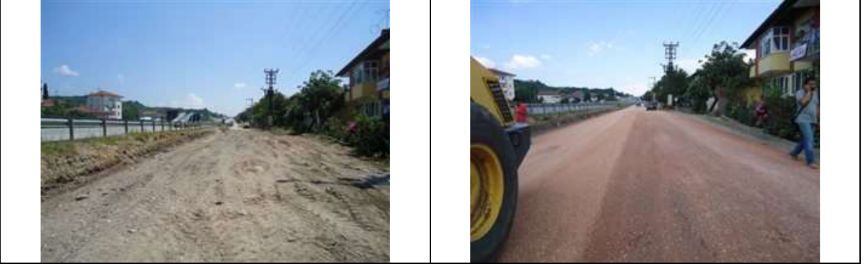
Eşme D-100 yan yol asfalt serim çalışması 2. Etap çalışma 110 mt. Uzunluğunda 8 mt. Genişliğinde yola 2100 ton asfalt serildi.
