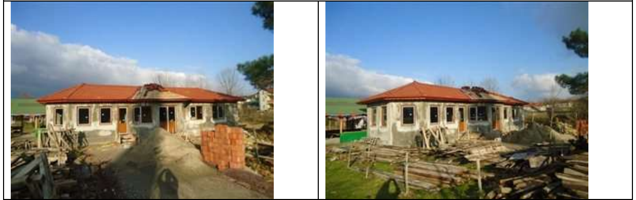
Uzuntarla Muhtarlık ve Bilgi Evi İnşaatı
