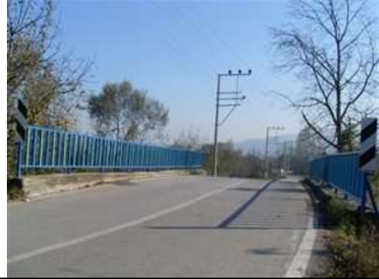
Arslanbey Adnan Menderes ve orta mahalleler arasındaki geçişin sağlanabilmesi için için 12 mt uzunluğunda çelikköprü yapım çalışması.
