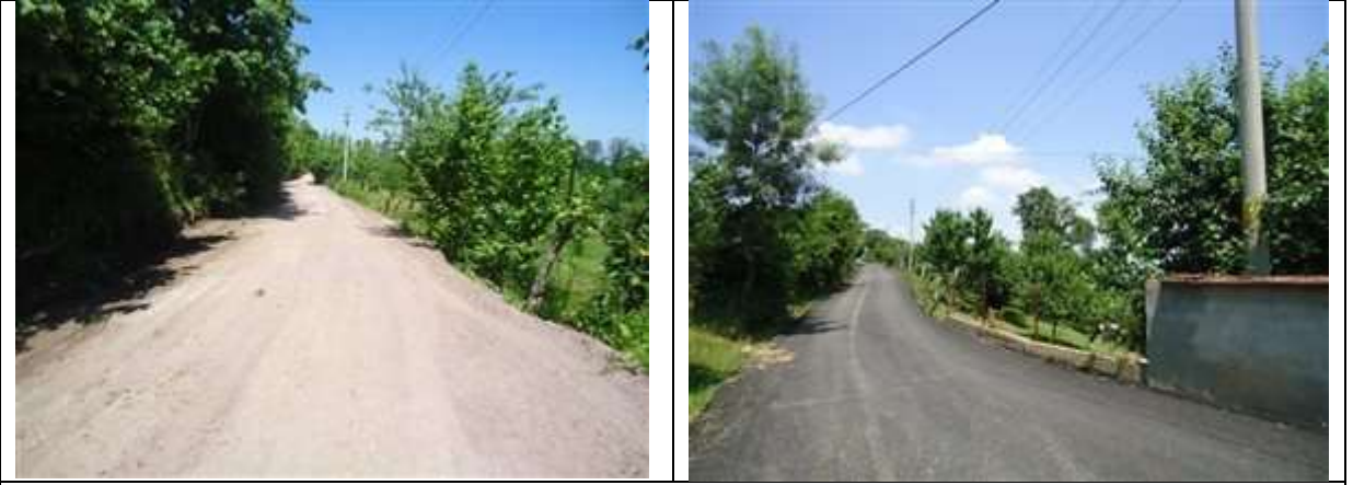
Suadiye Kartepe Mahallesi, Bahçelievler Sokak asfalt serim çalışması tamamlandı. 540 mt uzunluğunda 6 mt genişliğindeki yolda 780 ton asfalt serildi
