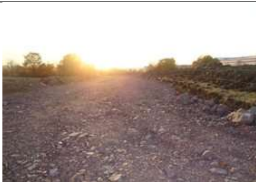
Acısu Yavuz Sultan Selim Mahallesi Çamlıdere Caddesi İmar yolu açılması işi 100 mt. Uzunluğunda 15 mt. Genişliğindeki yola 600 ton mekanik malzeme serildi.
