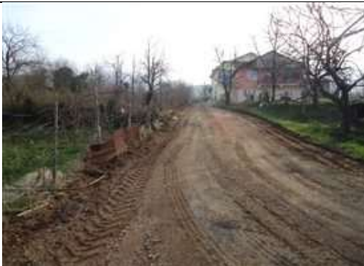
Derbent Hikmetiye Mahallesi İsimsiz Sokak Parke yol yapım işi 125 mt. Uzunluğunda 6 mt. Genişliğinde yolda 760 m2 parke bordür kullanıldı.
