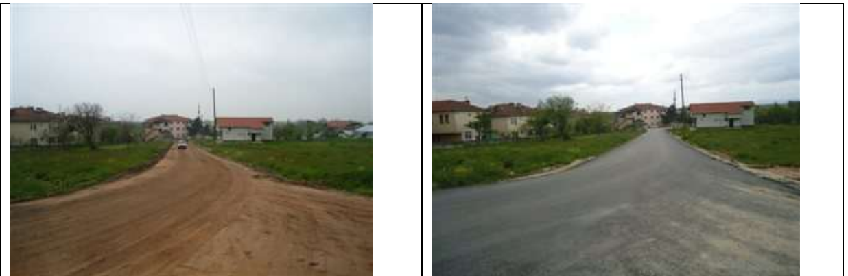
Uzuntarla İbrikdere Mahallesi 27 Sokak Asfalt Serim İşİ Tamamlandı. 130 mt uzunluğunda 6 mt genişliğindeki yola 90 ton asfalt serildi.
