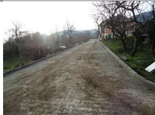
Derbent Hikmetiye Mahallesi İsimsiz Sokak Parke yol yapım işi 125 mt. Uzunluğunda 6 mt. Genişliğinde yolda 760 m2 parke bordür kullanıldı.
