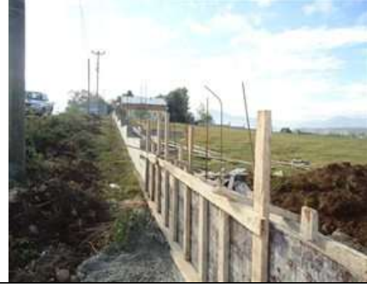
Atakent Rahmiye Mahallesi Yeşilkent mezarlığı beton duvar yapım işi 442mt uzunluğunda 280 m3 beton kullanıldı.
