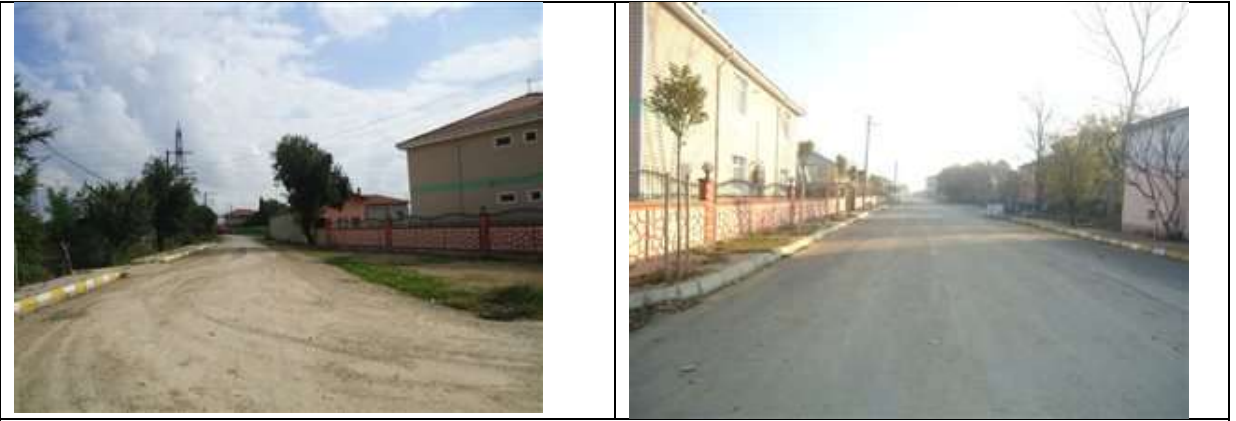
Uzunçiftlik Uzunbey Mahallesi Güneş Caddesi asfalt serim işi. 200 mt. Uzunluğunda 10 mt. Genişliğindeki yola 480 ton asfalt serildi.
