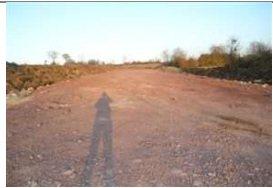
Acısu Yavuz Sultan Selim Mahallesi Çamlıdere Caddesi İmar yolu açılması işi 100 mt. Uzunluğunda 15 mt. Genişliğindeki yola 600 ton mekanik malzeme serildi.
