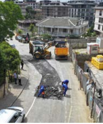
Güzeltepe Mah. Pelin Sk. Asfalt Yama Çalışması
