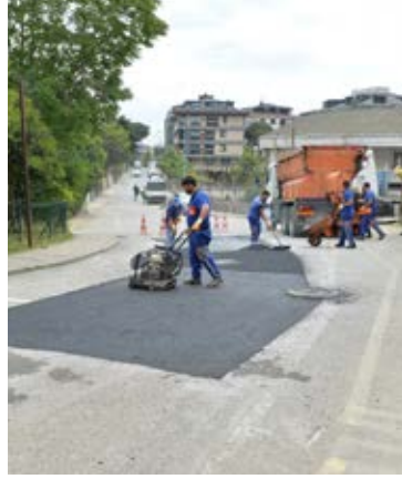
Güzeltepe Mah. Pelin Sk. Asfalt Yama Çalışması
