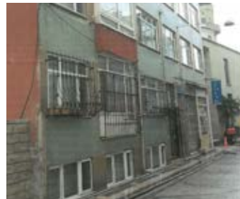
6306 Sayılı Kanun kapsamında Riskli Yapı tespit edilen binanın önceki hali
