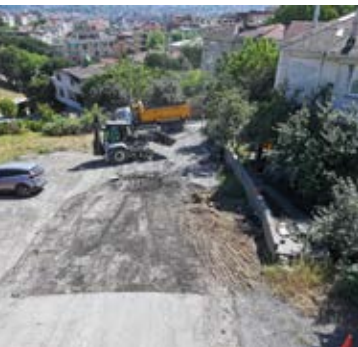
Ferah Mah. Çeşme Sk. Asfalt Yama Çalışması
