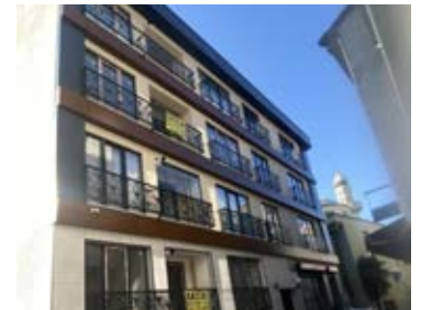
Alanın dönüşümden sonraki hali
