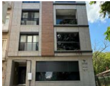
Alanın dönüşümden sonraki hali
