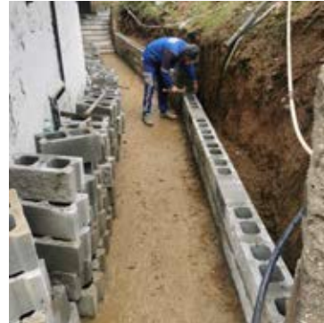
Mehmet Akif Ersoy Mah. Görele Sk. Briket Duvar Çalışması
