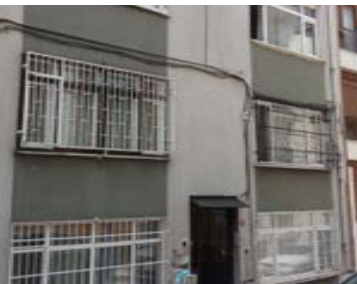
6306 Sayılı Kanun kapsamında Riskli Yapı tespit edilen binanın önceki hali
