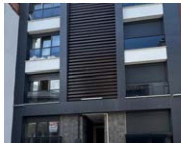
Alanın dönüşümden sonraki hali
