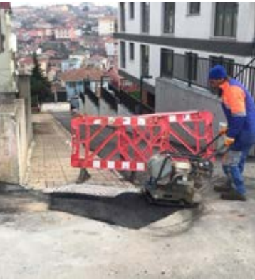
Asfalt Yama Çalışması
