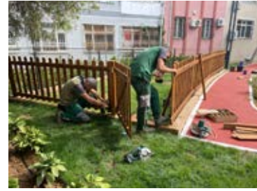
Ahşap Korkuluk Montajları
