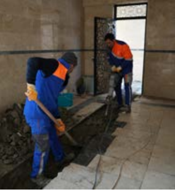
Yavuztürk Camii Kanalizasyon Çalışması
