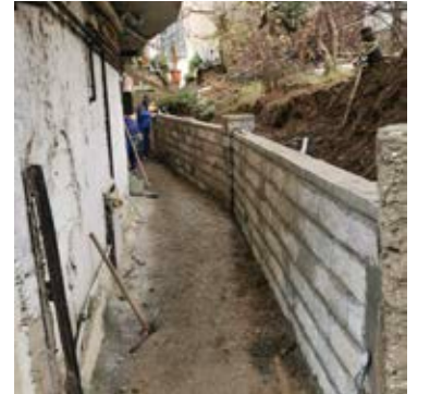
Mehmet Akif Ersoy Mah. Görele Sk. Briket Duvar Çalışması
