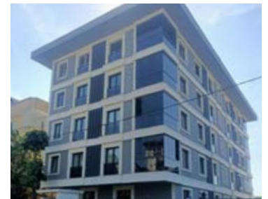
Alanın dönüşümden sonraki hali
