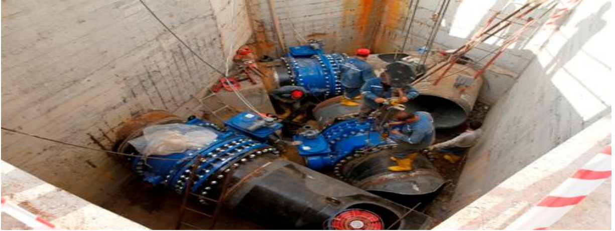
İçme Suyu Arıtma Tesisi Vana Değişimi
