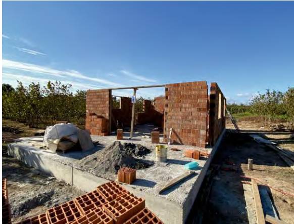
Yapı Kontrol Durdurma İşlemi
