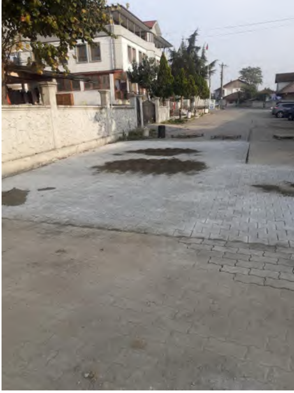
Mahalle Bazlı Kilit Parke Bakım Onarım Bilgileri
