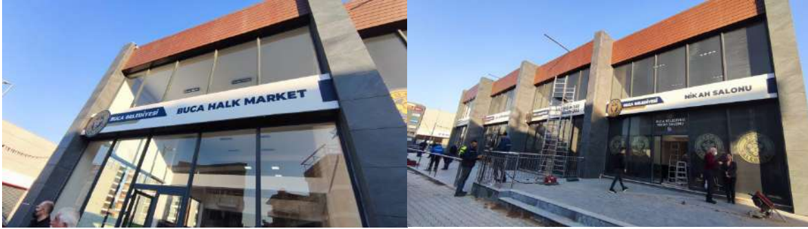
8339 ADA 1 PARSELDE BULUNAN YAPININ TADİLATLARININ YAPILMASI İŞİNDEN GÖRÜNTÜLER ( SOSYAL MARKET, EĞİTİM MERKEZİ, BELEDİYE EK BİNASI, NİKÂH SALONU )
