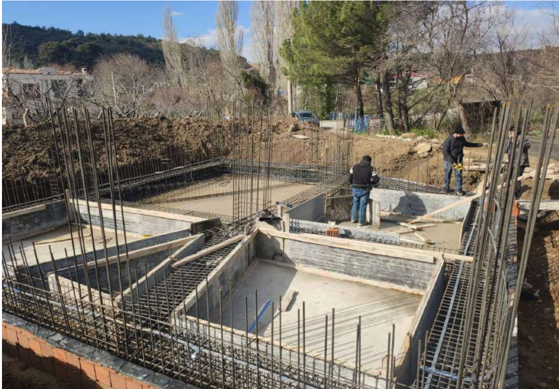
İNŞAAT AŞAMASINA BAŞLAYAN BİNALARIN TEMEL KOT KONTROLÜ
