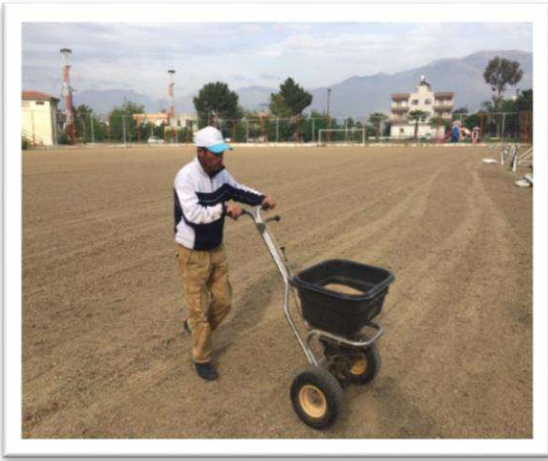
Arsuz Karaağaç Spor Tesisi Çim Saha Yenileme Çalışması
