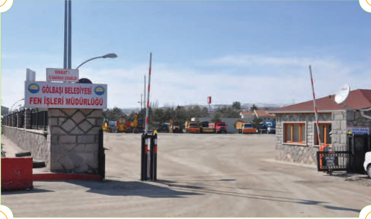
Belediye İşletme Binası (Şafak Mah.): 2.500 m 2 lik kapalı alanda Fen İşleri ile Park ve Bahçeler Müdürlükleri ve Veteriner İşleri Müdürlüğü tarafından hizmet verilmektedir.
