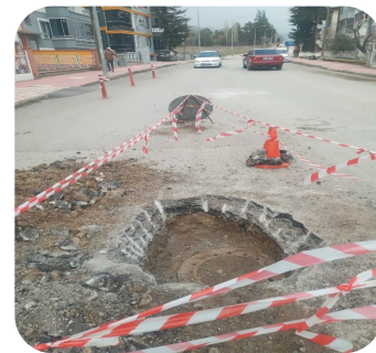
Şekil 45. Su kanal çalışmaları için güvenlik önlemleri.
