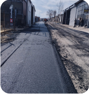
Şekil 87. Sıcak asfalt çalışmaları.
