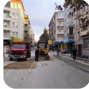
Şekil 43. Fen İşleri Müdürlüğü yol çalışmaları için trafik düzenlemesi.
