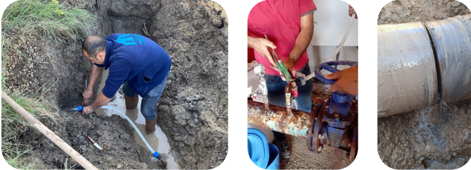
Şekil 20. Su arızaları bakım onarım çalışmaları.
