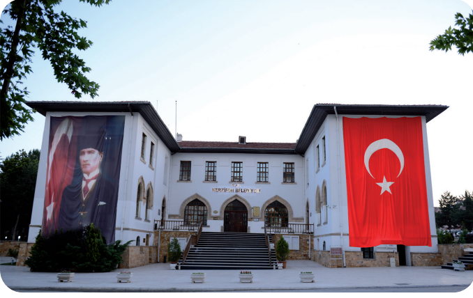
Şekil 3. Belediye Hizmet Binası
