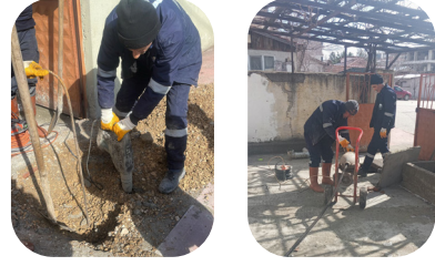
Şekil 22. Kanalizasyon hattı bakım onarım çalışmaları.
