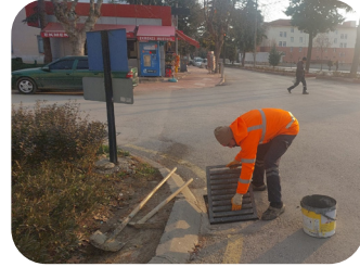
Şekil 23. Mazgalların temizlenme çalışmaları.
