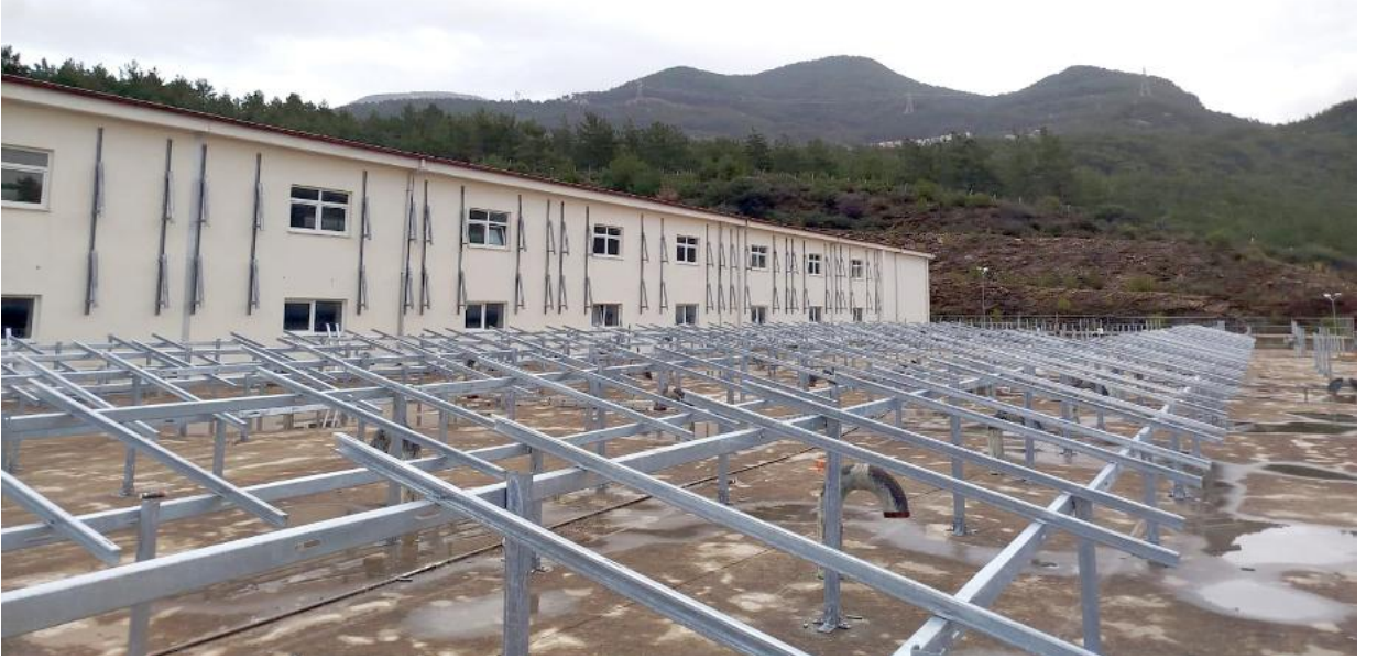
ASAT Alanya İçmesuyu Arıtma Tesisi GES Kurulum Çalışmaları (0,765 MWp)
