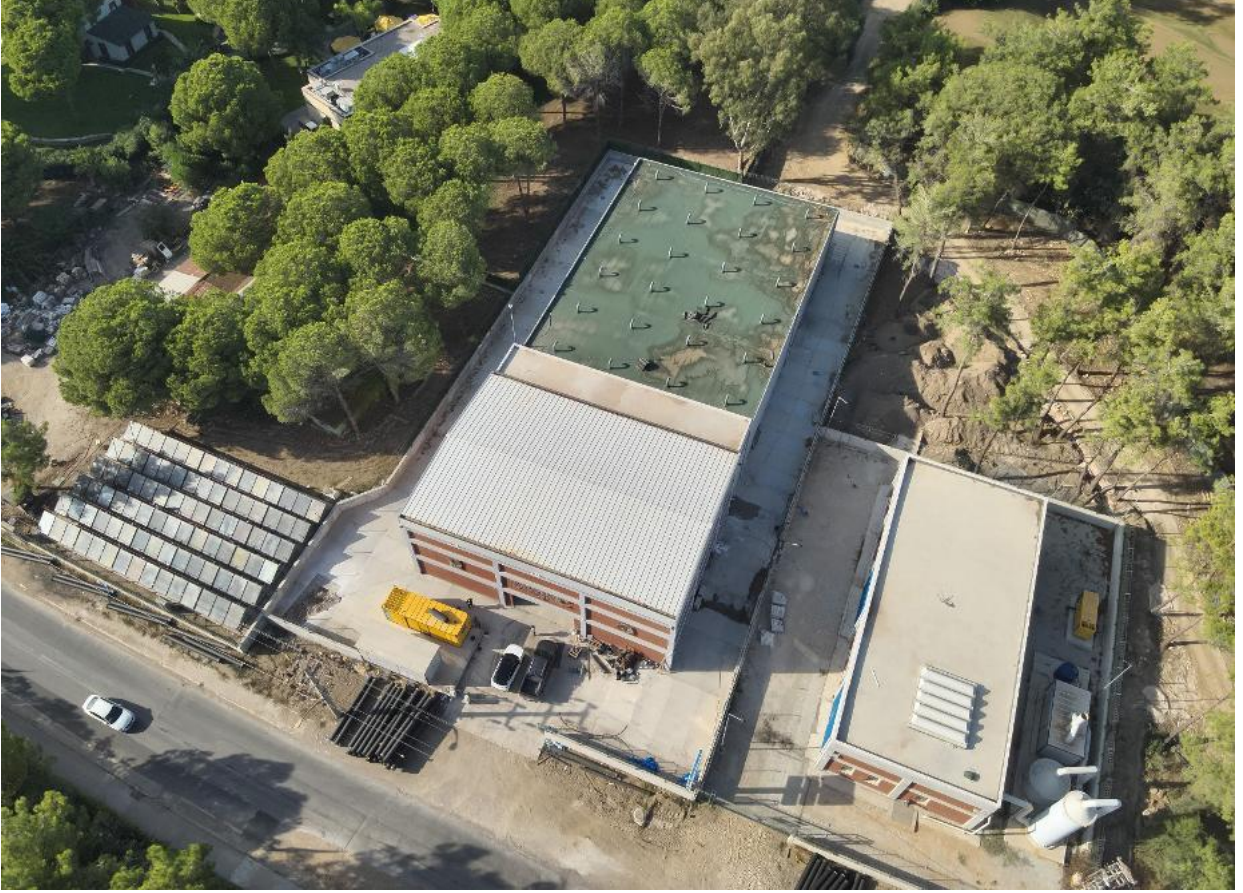
ASAT Belek 7500 m3 İçmesuyu Deposu GES Kurulum Çalışmaları (0,204 MWp)
