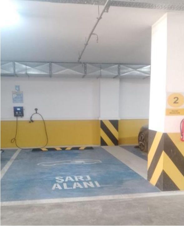
ASAT ANA HİZMET BİNASI -1 OTOPARK ARAÇ ŞARJ İSTASYONU ZEMİN VE DUVAR BOYA YAPIM İŞİ
