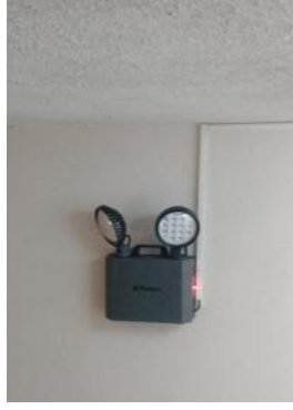
YANGI MERDİVENİ ACİL KAÇIŞ KORIDORLARI YANGIN YÖNETMELİĞİ GEREĞİ 30 ADET AKÜLÜ ACİL AYDINLATMA ARMATÜRÜ VE 40 ADET ACİL ÇIKIŞ EXIT TAKILMIŞTIR
