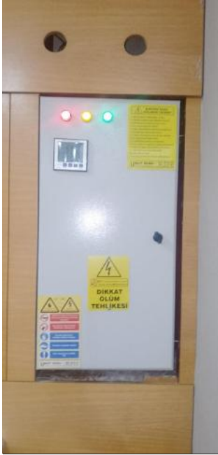
ASAT MERKEZ BİNASI 4 ADET VRF KLİMA LARIN BESLEME PANOLARININ DEĞİŞİMİ
