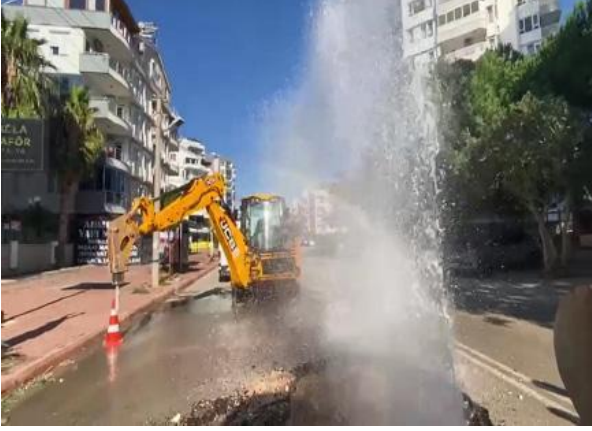
Konyaaltı İlçesi, Liman Mahallesi, 3079 Bileydiler Caddesi Ø110mm PE arıza tespiti.
