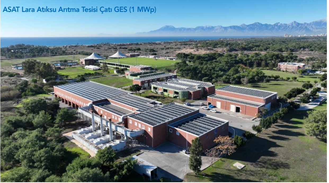
ASAT Lara Atıksu Arıtma Tesisi Çatı GES (1 MWp)
