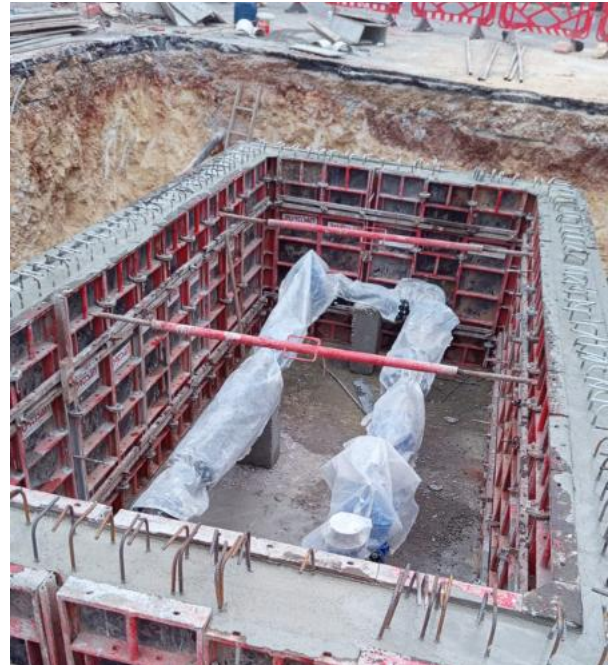
7026 Numaralı menhol DMA (bağımsız alt bölge) yapım işi
