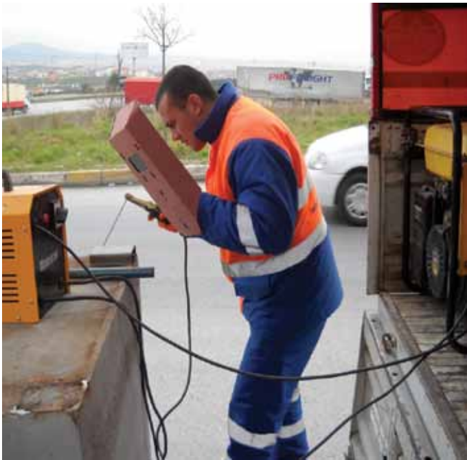
Araziden toplanan konteynerlerin tamir edilmesi çalışmaları.
