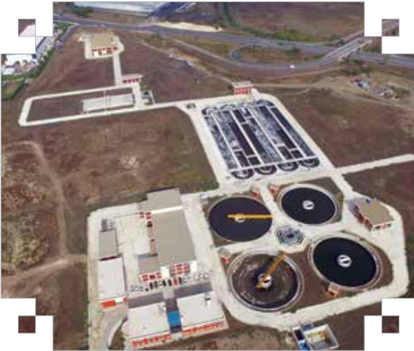
Çanta İleri Biyolojik Atık Su Arıtma Tesisi
