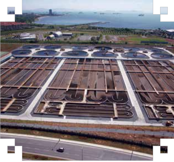
Ataköy İleri Biyolojik Atık Su Arıtma Tesisi
