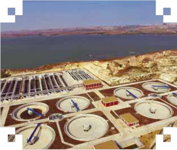
Büyükçekmece İleri Biyolojik Atık Su Arıtma Tesisi
