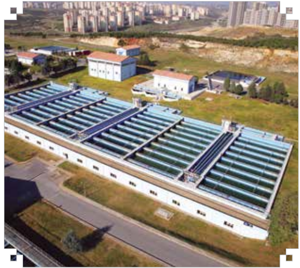
İkitelli İçme Suyu Arıtma Tesisleri
