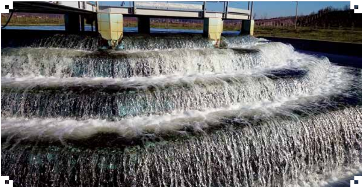
Cumhuriyet İçme Suyu Arıtma Tesisi
