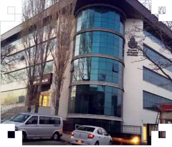
Eyüp Hizmet Binası
