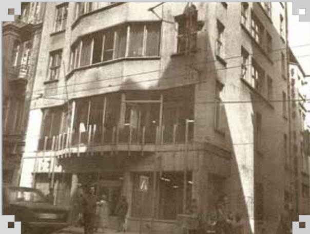
İSİ Binası Beyoğlu - 1935
