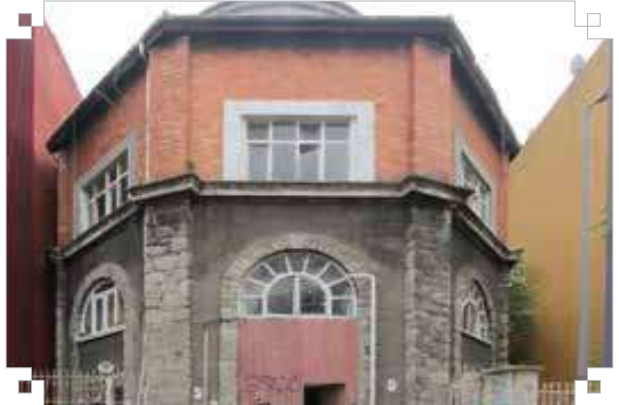
Şişli Eski Su Deposu (Şato) Yapısı Onarım Projesi
