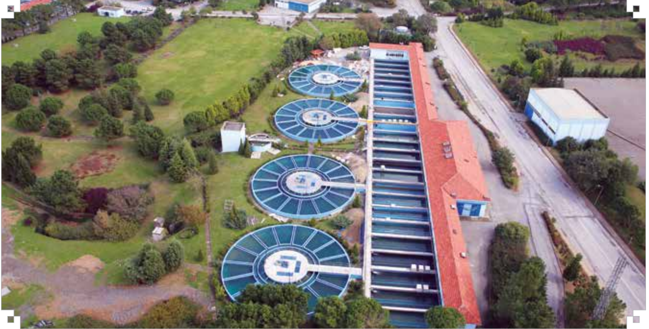
Ömerli İçme Suyu Arıtma Tesisi
