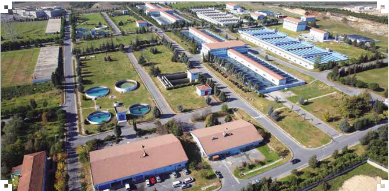
İkitelli İçme Suyu Arıtma Tesisi
