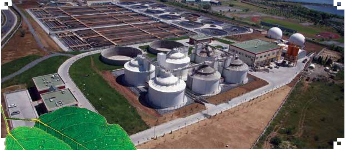
Ataköy İleri Biyolojik Atık Su Arıtma Tesisi
