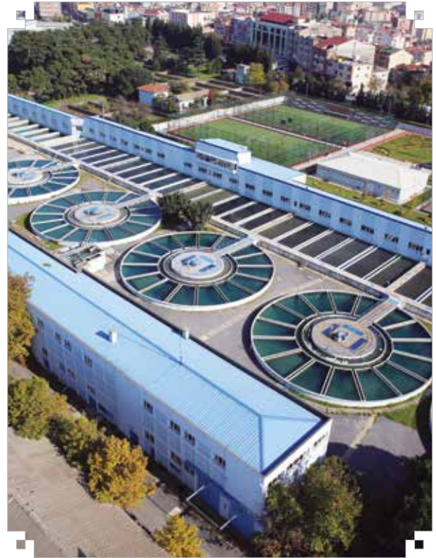
Kağıthane İçme Suyu Arıtma Tesisi
