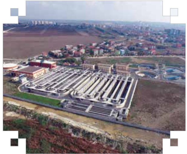
Silivri İleri Biyolojik Atık Su Arıtma Tesisi
