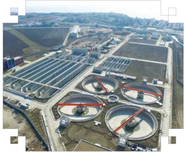
Selimpaşa İleri Biyolojik Atık Su Arıtma Tesisi
