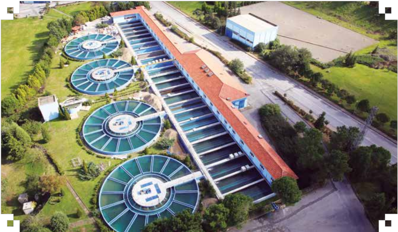
Ömerli İçme Suyu Arıtma Tesisi
