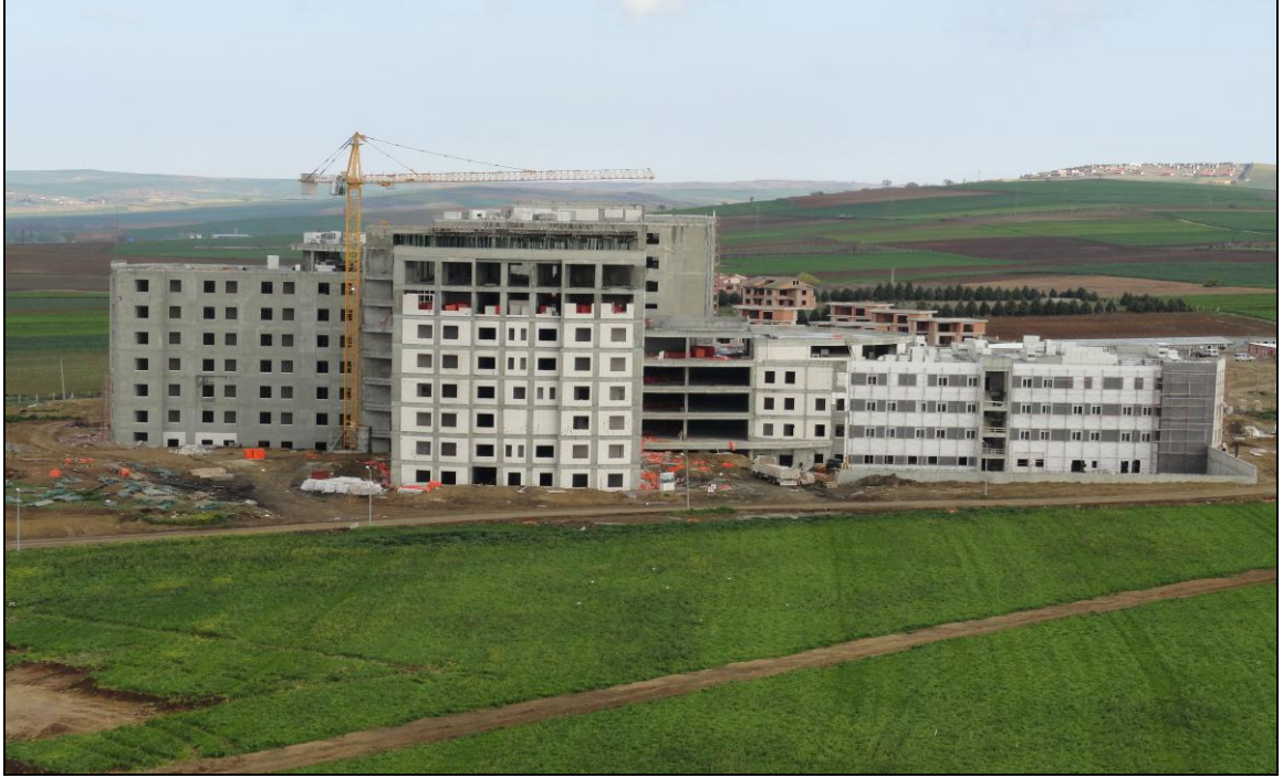
Resim 30: 200 Yataklı Araştırma ve Uygulama Hastanesi İnşaatı
