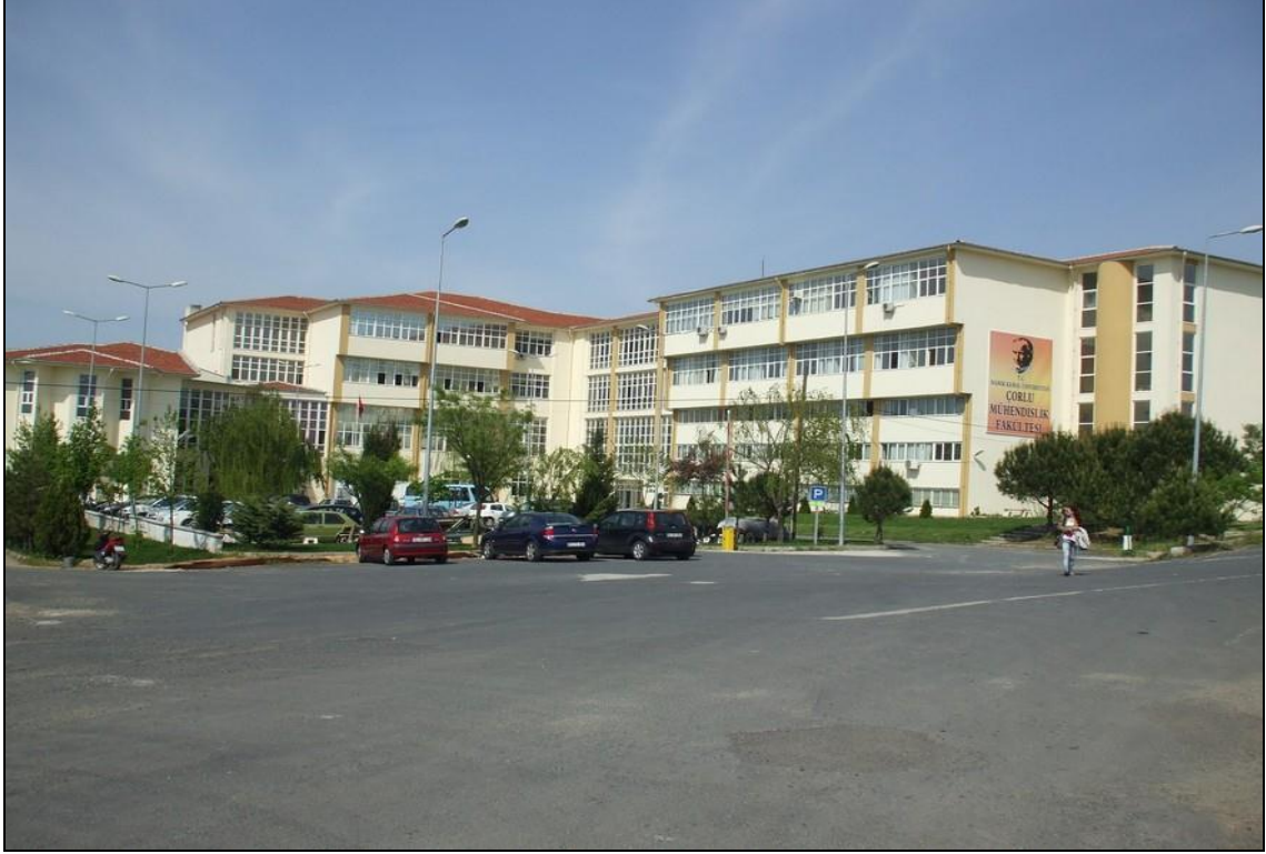
Resim 9: Çorlu Mühendislik Fakültesi Dekanlık Binası
