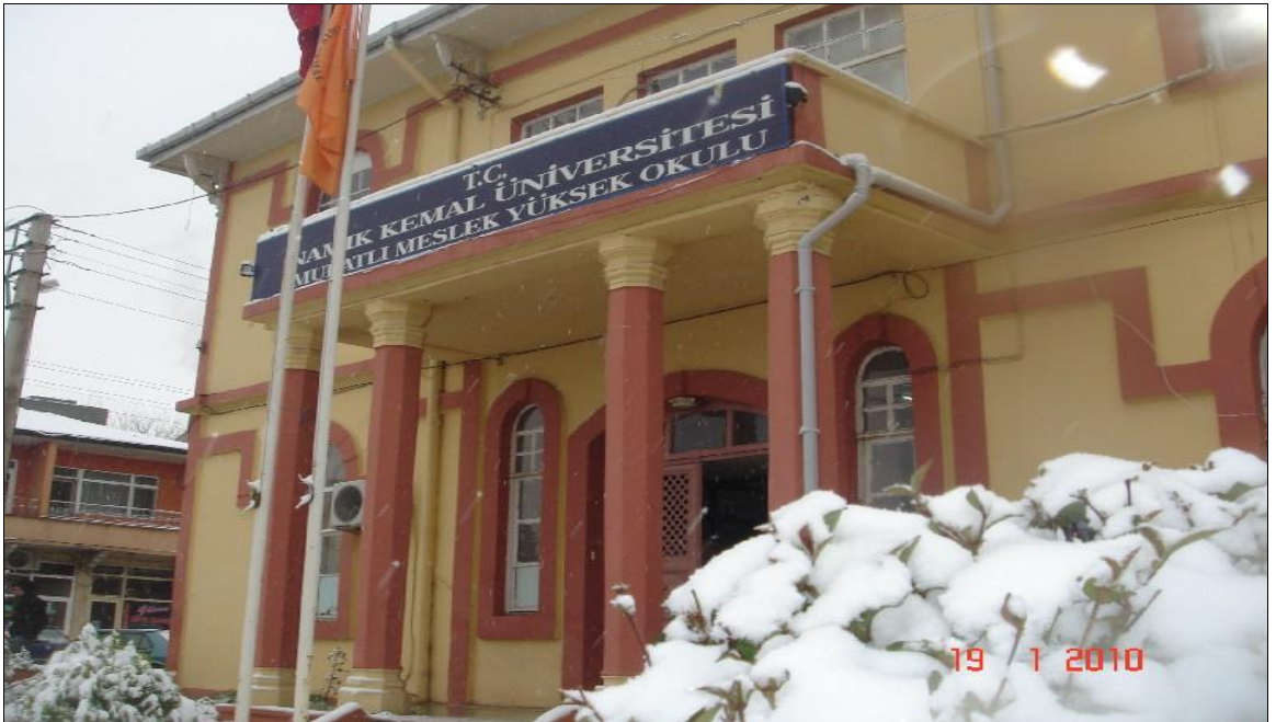
Resim 25: Muratlı Meslek Yüksekokulu Binası
