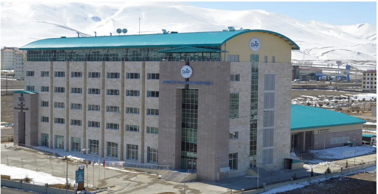
Resim 1: DAP Bölge Kalkınma İdaresi Hizmet Binası
