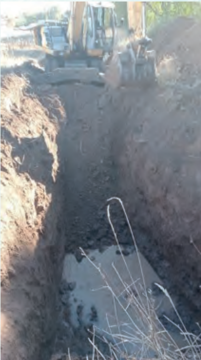
Köy Çeşmesi Su Hattı Kazısı Yapılması
