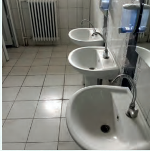
İlköğretim Okulu Tadilatının Yapılması (Lavabo Bataryaları Yenilenmesi)
