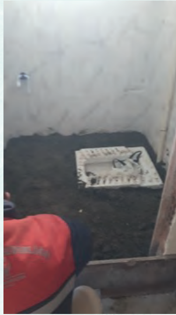
Köy Odası WC Tadilatının Yapılması (Mevcut Klozetin Alaturkaya Dönüştürülmesi)
