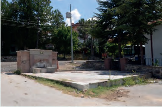
Köy Çeşmesi Tadilatının Yapılması ve Panel Çit İle Çevrilmesi
