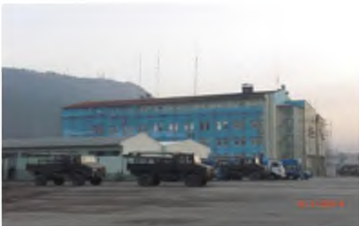
Tokat İl J.K.Lığı Binası Çatı Yapımı
