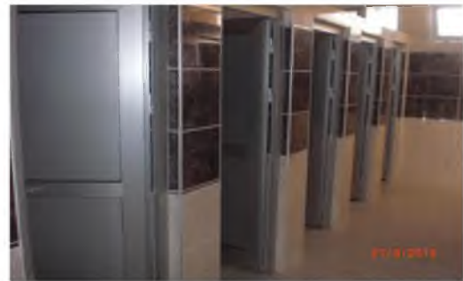
Başçiftlik İlçe J.K.lığı Bakım-Onarım
