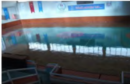
Turhal Spor salonu Bakım-Onarım
