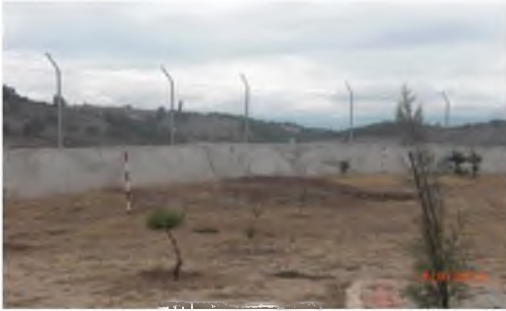
Turhal J.Komd. Tb. K.lığı İhata Duvarı
