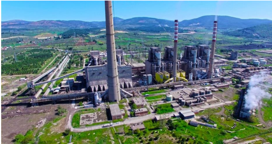
Soma Termik Santrali
