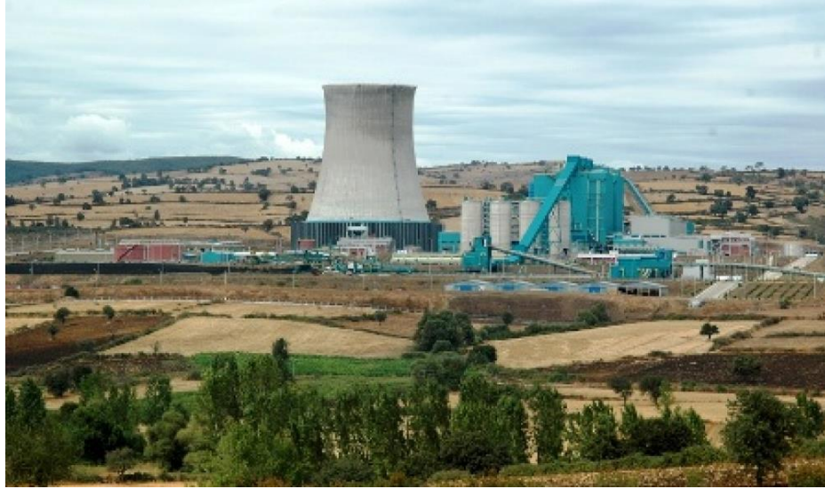
EÜAŞ 18 Mart Termik Santrali
