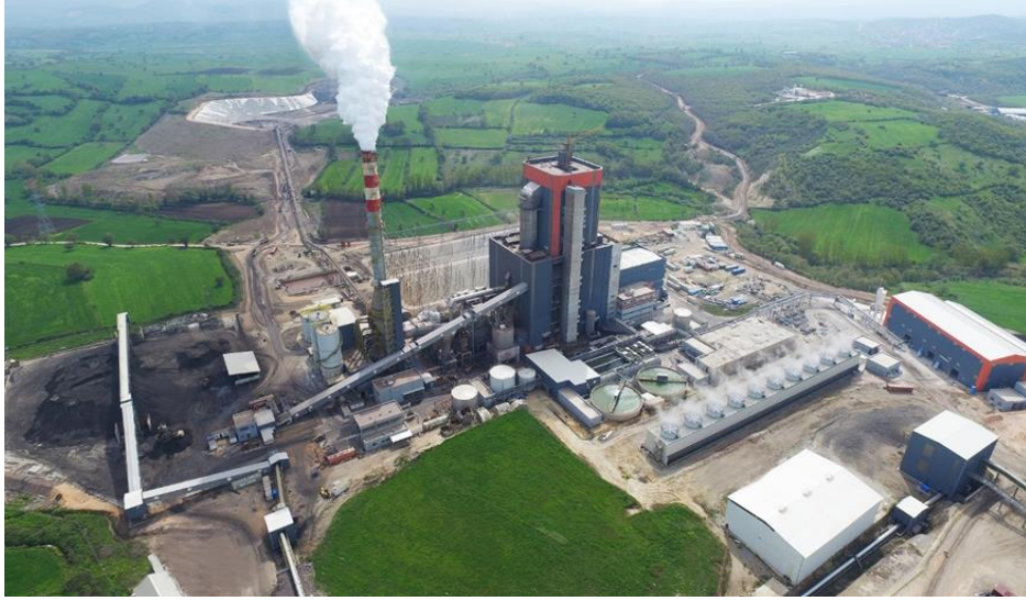
Odaş Termik Santrali
