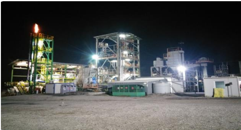
250 kg/h Kapasiteli Sürüklemeli Tip Gazlaştırıcı ve Gaz Temizleme Ünitesi
