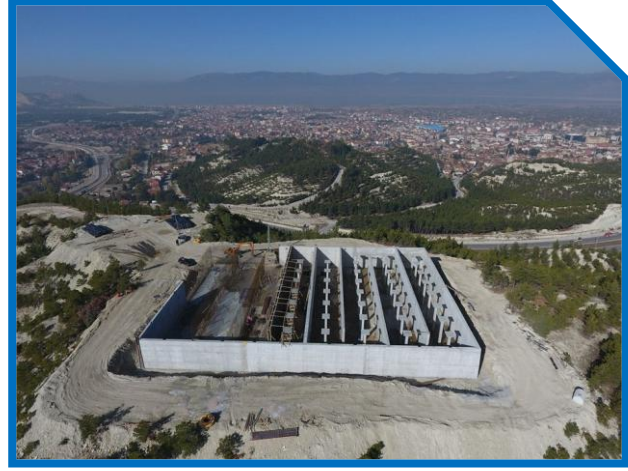
DSİ 10.000m 3 lük Depo İnşaatı
