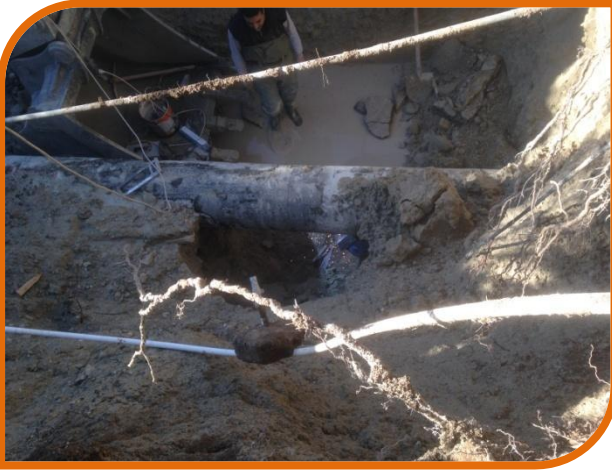
Çelik depo hattının kaynak işlemi tamamlandı.
