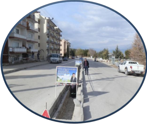
ATATÜRK MAHALLESİ ZEYNEL ABİDİN TONGUÇ CADDESİ ORTA REFÜJ ÇALIŞMASI
