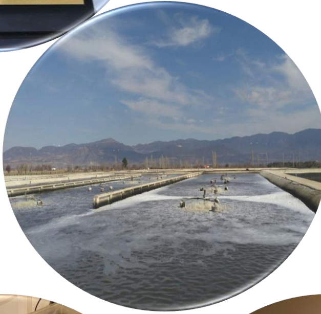
Atıksu Arıtma Tesisi
