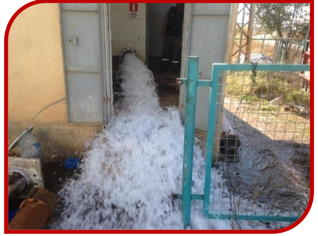
Tamirâtı yapılan kuyu görüntüsü
