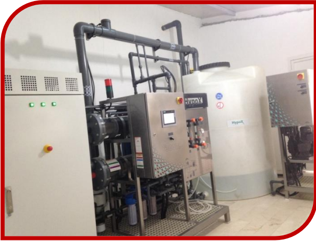
Klor jeneratörünün periyodik bakımları yapıldı
