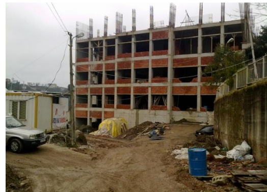
MYO Ek Bina İnşaatı
