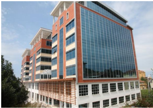
Fen Edebiyat Fakültesi A-B-C Blok İnşaatı
