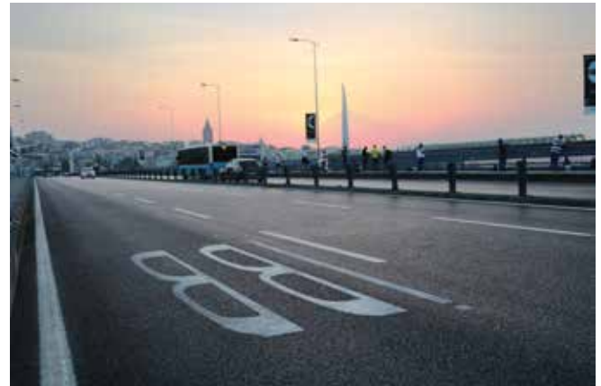
Unkapanı Köprüsü Asfalt Çalışması, Fatih
