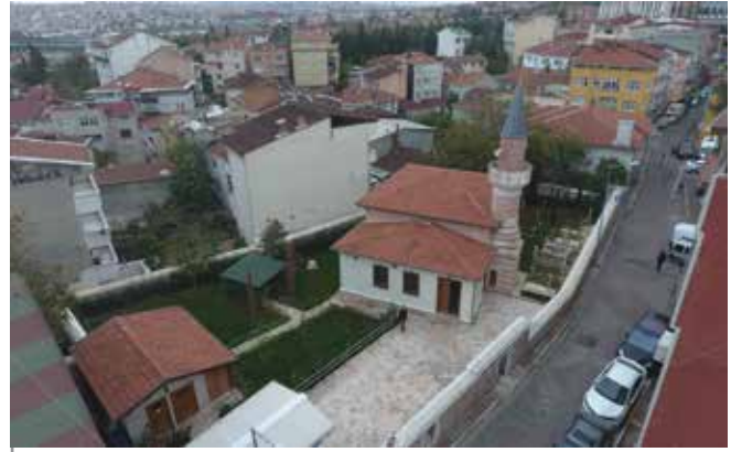
Davutağa Camii Restorasyonu, Eyüpsultan
