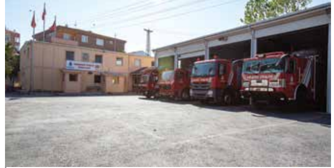
Hadımköy İtfaiye İstasyonu, Arnavutköy
