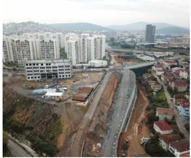
Osmangazi Caddesi ve Yakacık Caddesi Arası İmar Yolu, Sancaktepe
