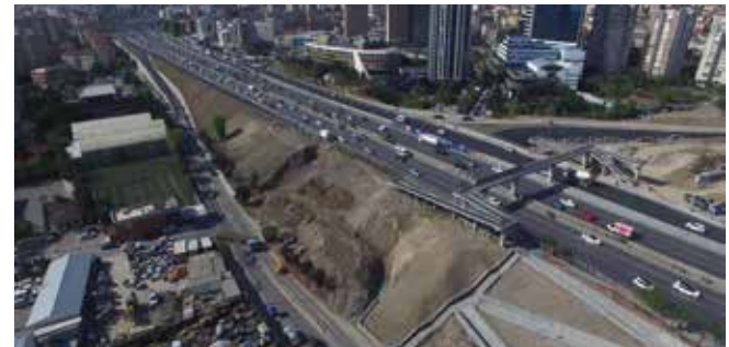
D-100 Karayolu-Bostancı Kavşağı - Küçükyalı Kavşağı Arası Yan Yollar Düzenleme, Maltepe
