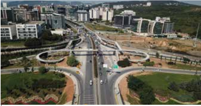
Kavacık Kavşağı ve Çevresi Yol Düzenlemesi, Beykoz
