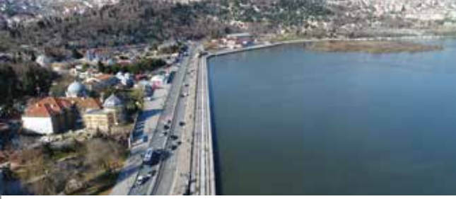
Eminönü-Eyüpsultan-Alibeyköy Tramvay Hattı Kazıklı Yol Köprüsü
