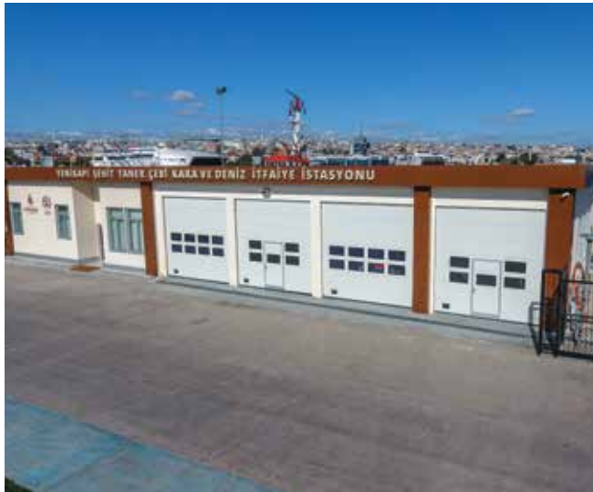
Yenikapı Kara ve Deniz İtfaiye Binası, Fatih
