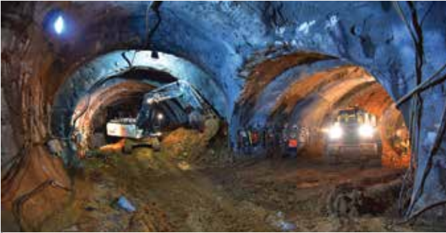
Veysel Karani İstasyonu, Çekmeköy-Sultanbeyli Metro Hattı ile Hastane - Yenidoğan Metro Hattı
