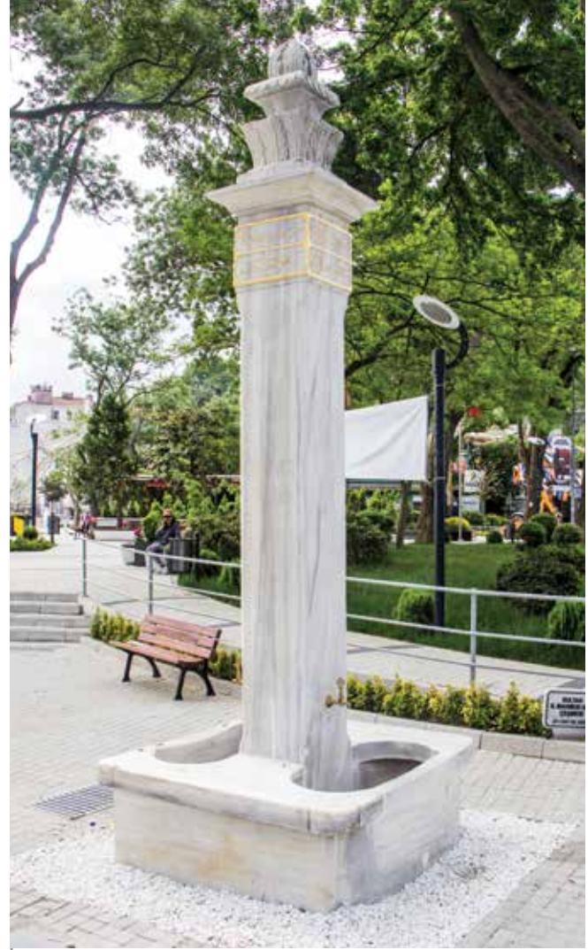
II. Mahmut Çeşmesi Onarımı
