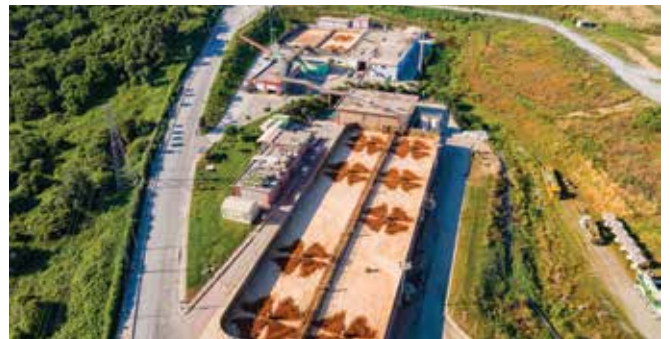
Odayeri Sızıntı Suyu Arıtım Tesisi, Eyüpsultan
