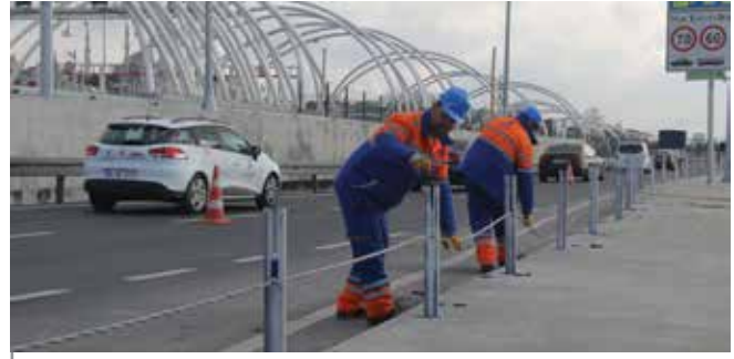
Yenikapı Sahilyolu Çelik Halat Çalışması, Zeytinburnu
