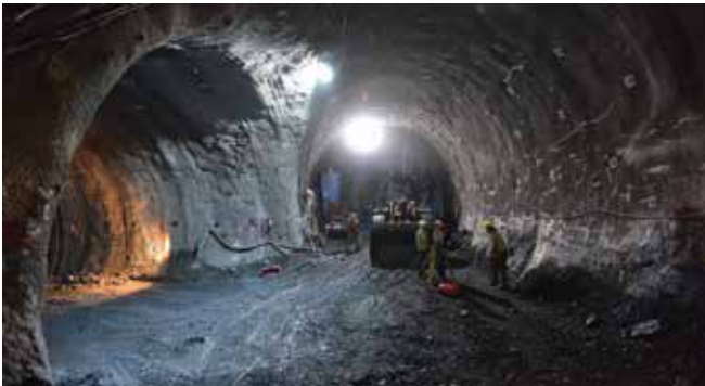
Meclis Mahallesi İstasyonu, Çekmeköy-Sultanbeyli Metro Hattı ile Hastane - Yenidoğan Metro Hattı
