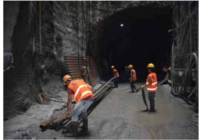
Başakşehir - Kayaşehir Metro Hattı
