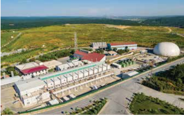
Odayeri LFG Enerji Üretim Tesisi 2, Eyüpsultan
