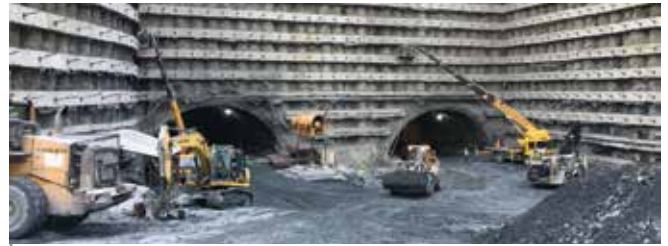
Dolmabahçe – Levazım Tüneli
