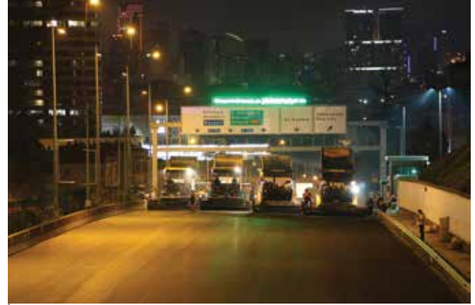
D-100 Karayolu Asfalt Çalışması, Kadıköy
