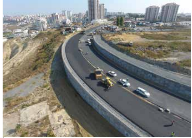
3 No.lu Yol, Başakşehir
