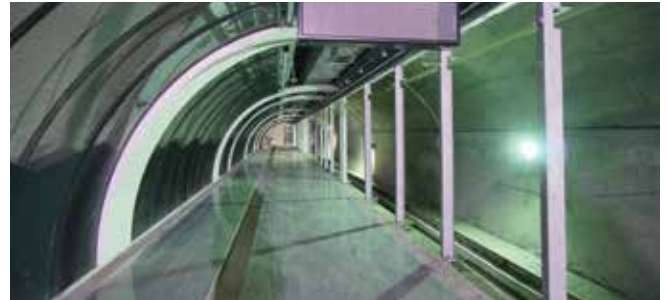
Çirçir İstasyonu, Kabataş-Mecidiyeköy-Mahmutbey Metro Hattı
