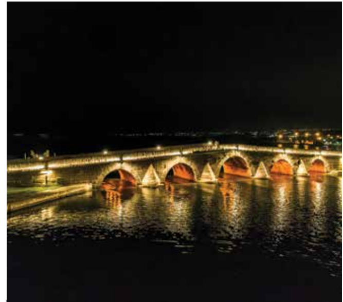
Büyücekmece Köprüsü, Büyücekmece
