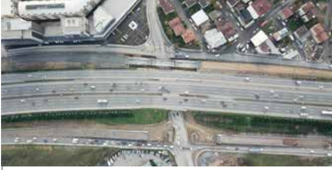
TEM Kuzey Güney Yan Yolları ile Ecol Caddesi Kesişim Köprüsü, Sultanbeyli
