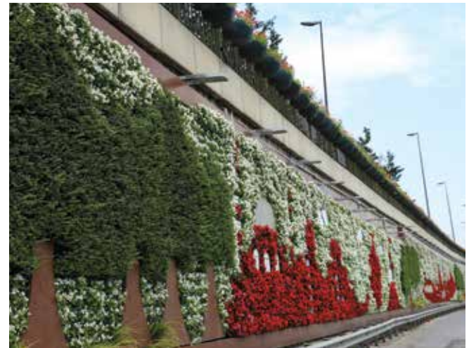
Altunizade Duvar Bahçe Uygulaması, Üsküdar
