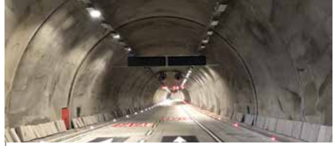
Libadiye-Çamlıca Karayolu Tüneli
