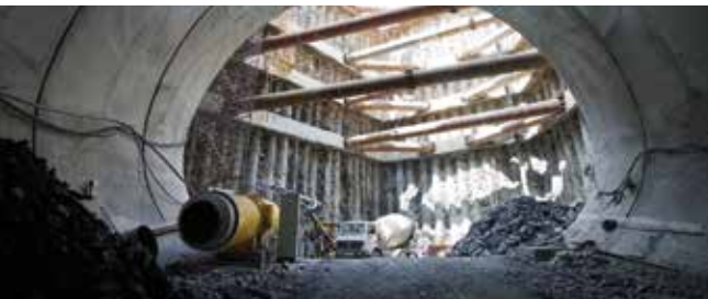
Hisarüstü İstasyonu, Rumeli Hisarüstü-Aşıyan Füniküler Hattı
