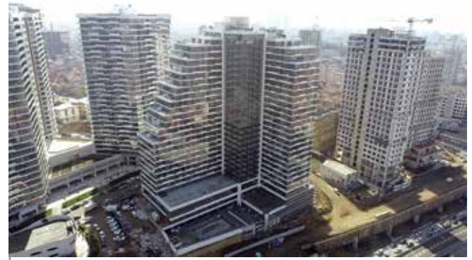
Kentsel Dönüşüm ve Yenileme Alanı Konut İnşaatları, Kadıköy Fikirtepe
