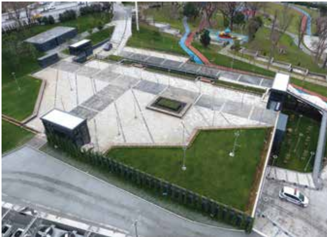
Küçükçekmece Belediye Yanı Zeminaltı Otopark ve Meydan Düzenleme, Küçükçekmece
