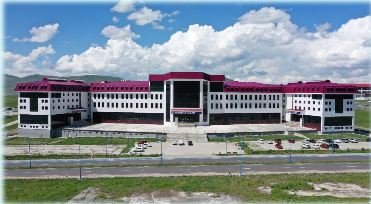
Ardahan Üniversitesi Mühendislik Fakültesi Binası
