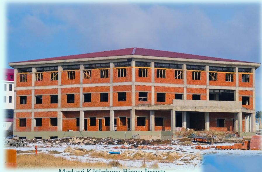
Merkezi Kütüphane Binası İnşaatı
