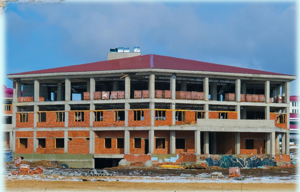
Merkezi Yemekhane Binası İnşaatı
