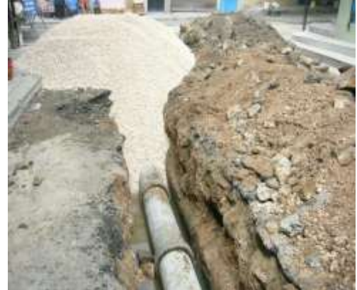
(Arızası giderilmiş kanalizasyon hattı)
