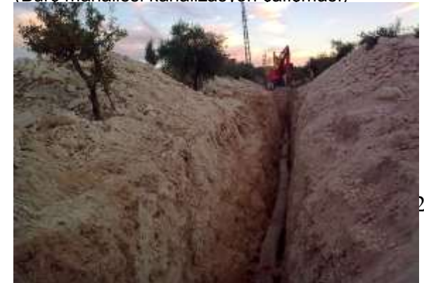
(Burc mahallesi kanalizasyon çalışması)
