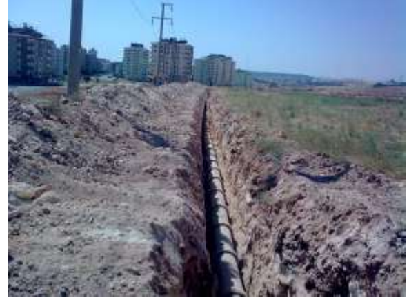
(Batıkent mah. N. Topçuoğlu Blv. Kanalizasyon çalış.)
