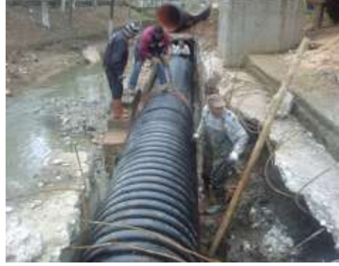
(Alleben Deresi kenarı kanalizasyon koruge boru deđiřimi)
