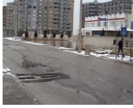
(Karataş mah. yağmursuyu altyapısı yapıldıktan sonraki hali)
