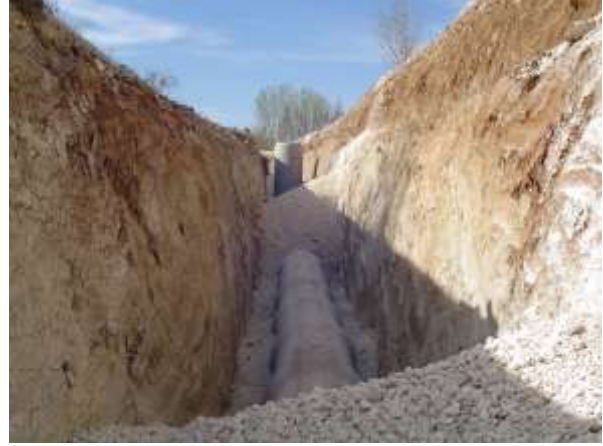
(3.atıksu arıtma tesisi inşaatı)
