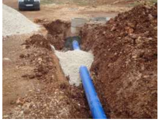
(İncilikaya mahallesi terfi hattı – yeni hali)
