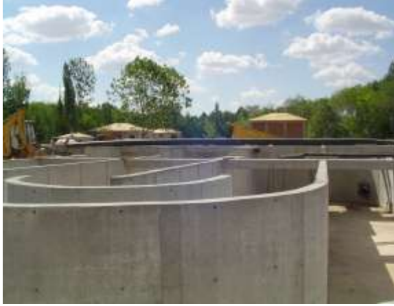
(Oğuzeli-Yeşildere ana kollektör hattı yapımı)
