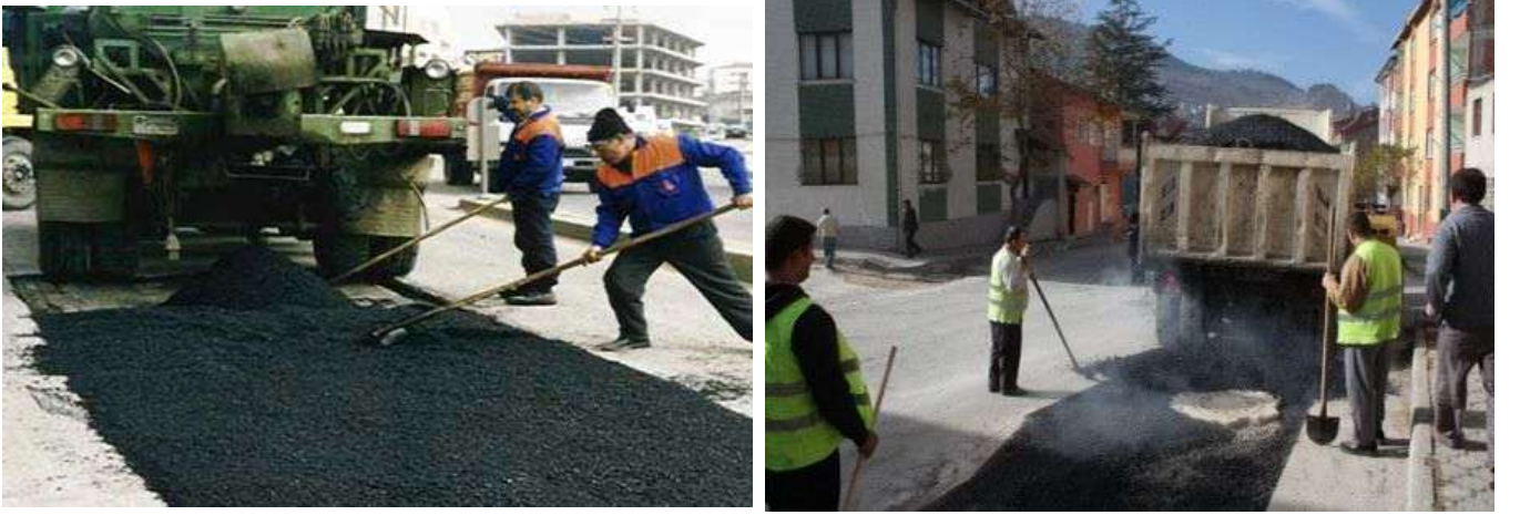
(Muhtelif Sokaklarda Yapılan Asfalt Yama Çalışmaları)
