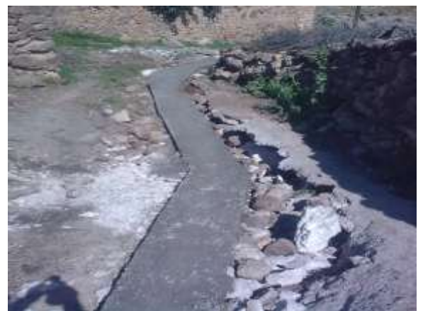
(Altınova köyü kanalizasyon çalışması)
