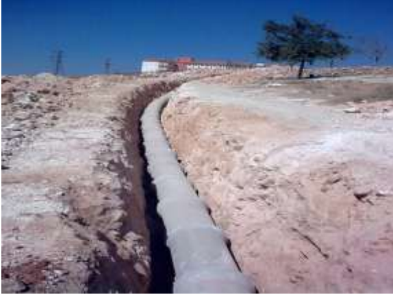
(Vatan mah. Kanalizasyon çalışması)
