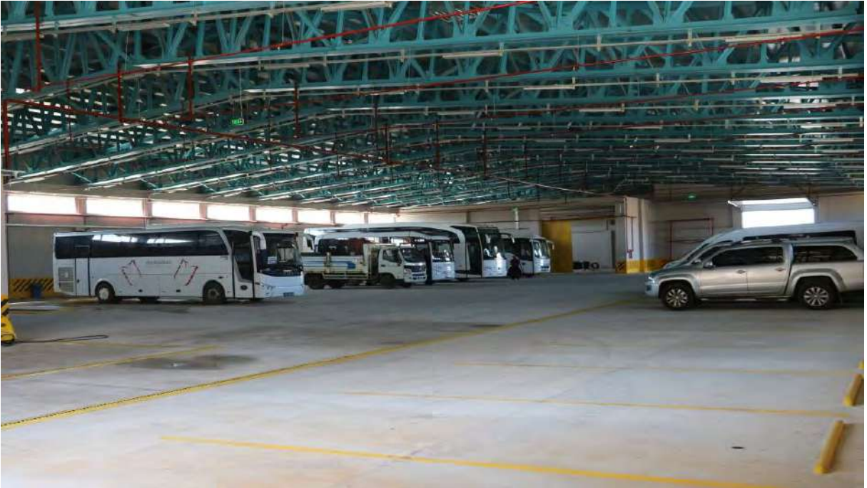
Resim 4. Hangar İç Görünüm
