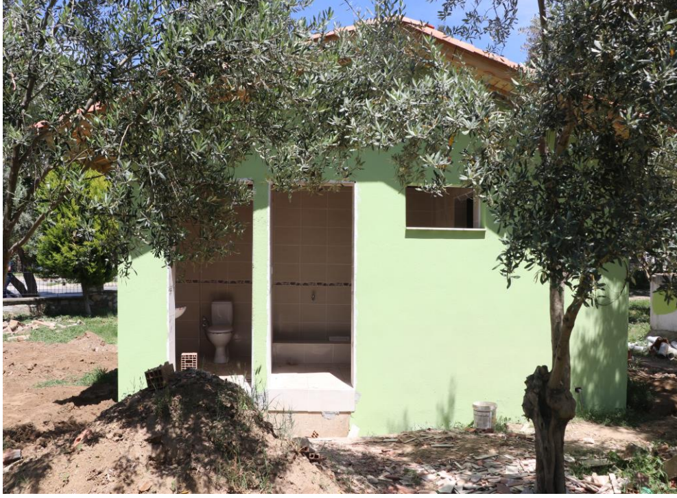
YAPIM SONRASI HALİ
