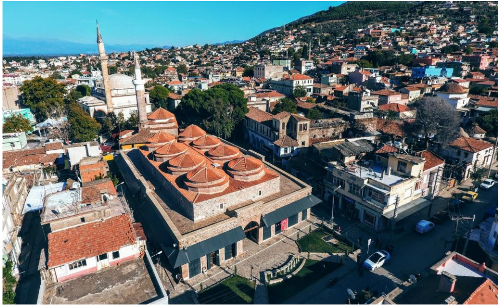
YALINAYAK HAMAMI RESTORASYONU
